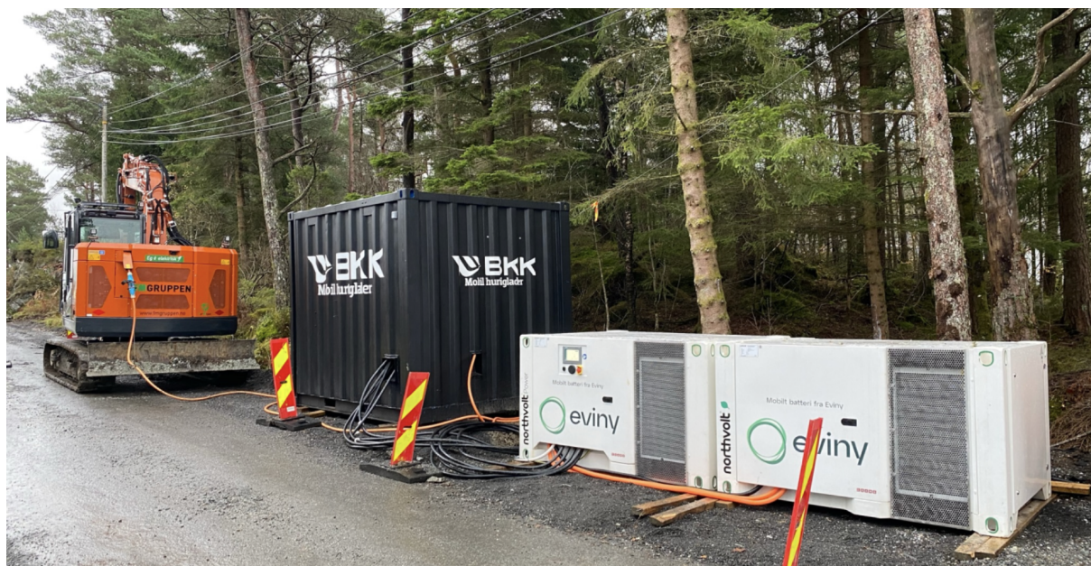
Figur 17: Fyllingen Maskin - Lading av elektrisk gravemaskin med mobilt batteri og hurtigladeconteniner fra Eviny (26).
