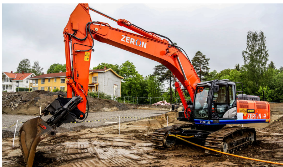
Figur 4: Elektrisk gravemaskin levert av Nasta AS (16).
