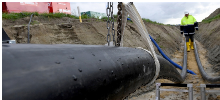
Figur 9: Legging av kraftkabler i Nordlink-prosjektet [19].
