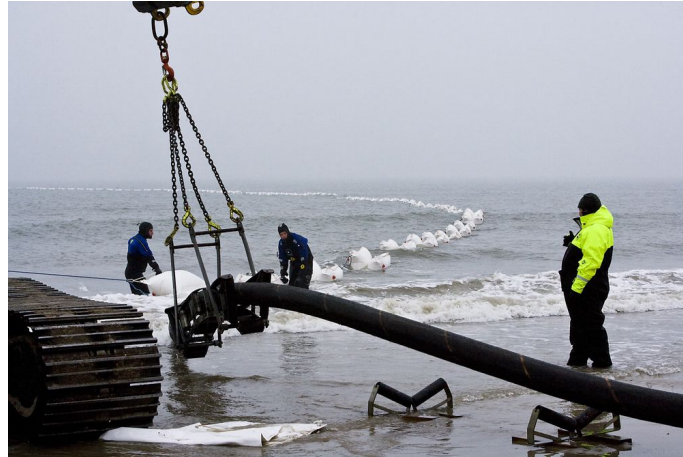
Figur 8: Trekking av undersjøiske kabler [17].
