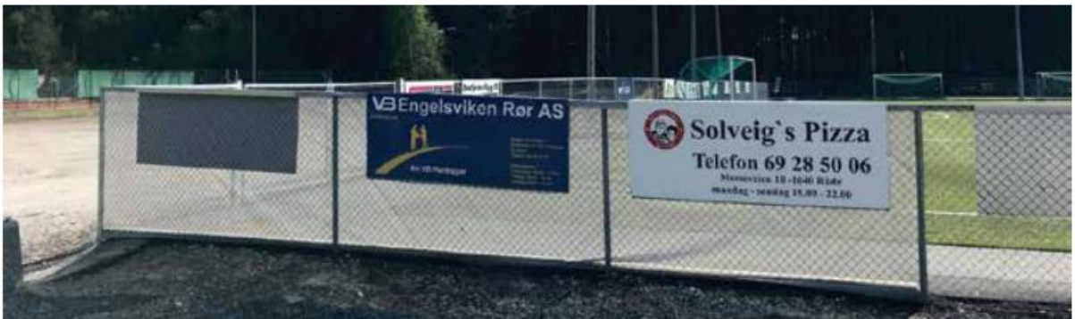
Figur 20 - Flettverksgjerde med barriereduk. (NFF, u.å.)
