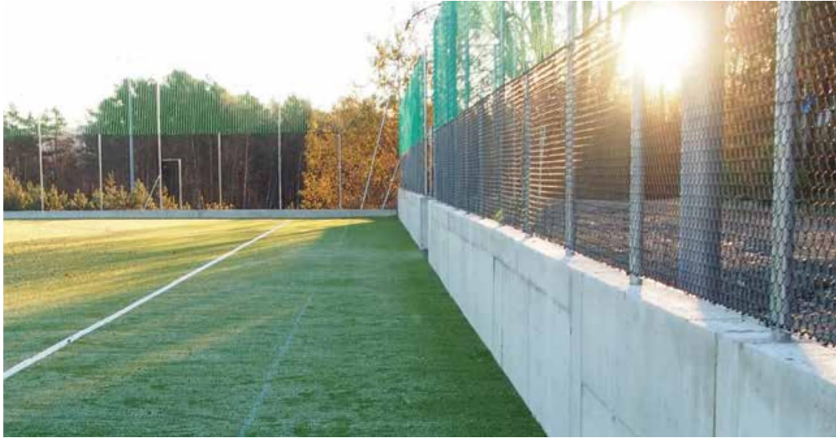
Figur 23 - Plass-støpt ringmur. (NFF, u.å.)
