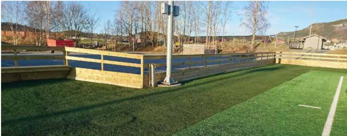
Figur 21 - Trykkimpregnert terrassebord montert på gjerdet. (NFF, u.å.)
