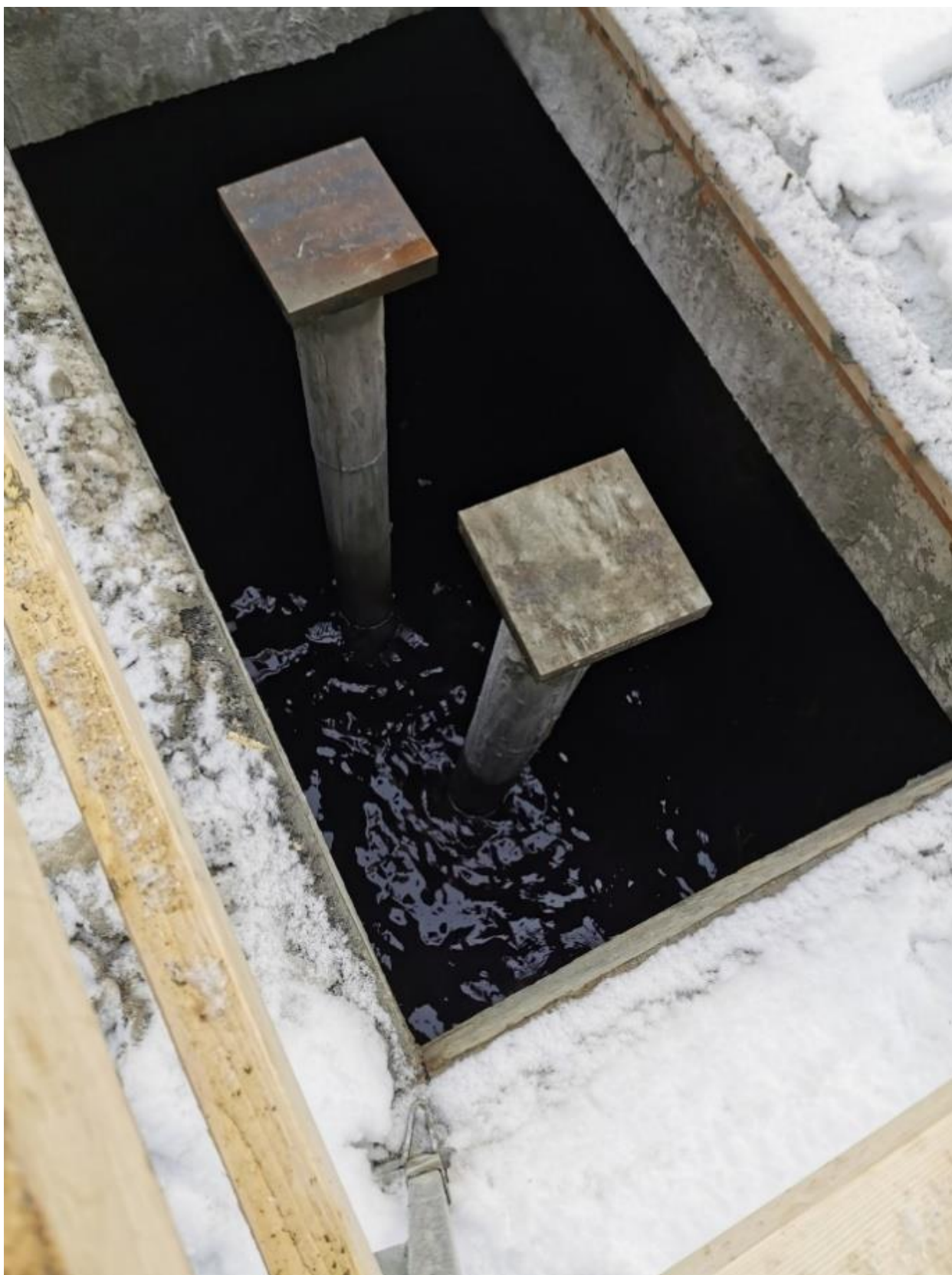
Figur 31 Den påbegynte heissjakt som forskales banker pelene med i fastberg
