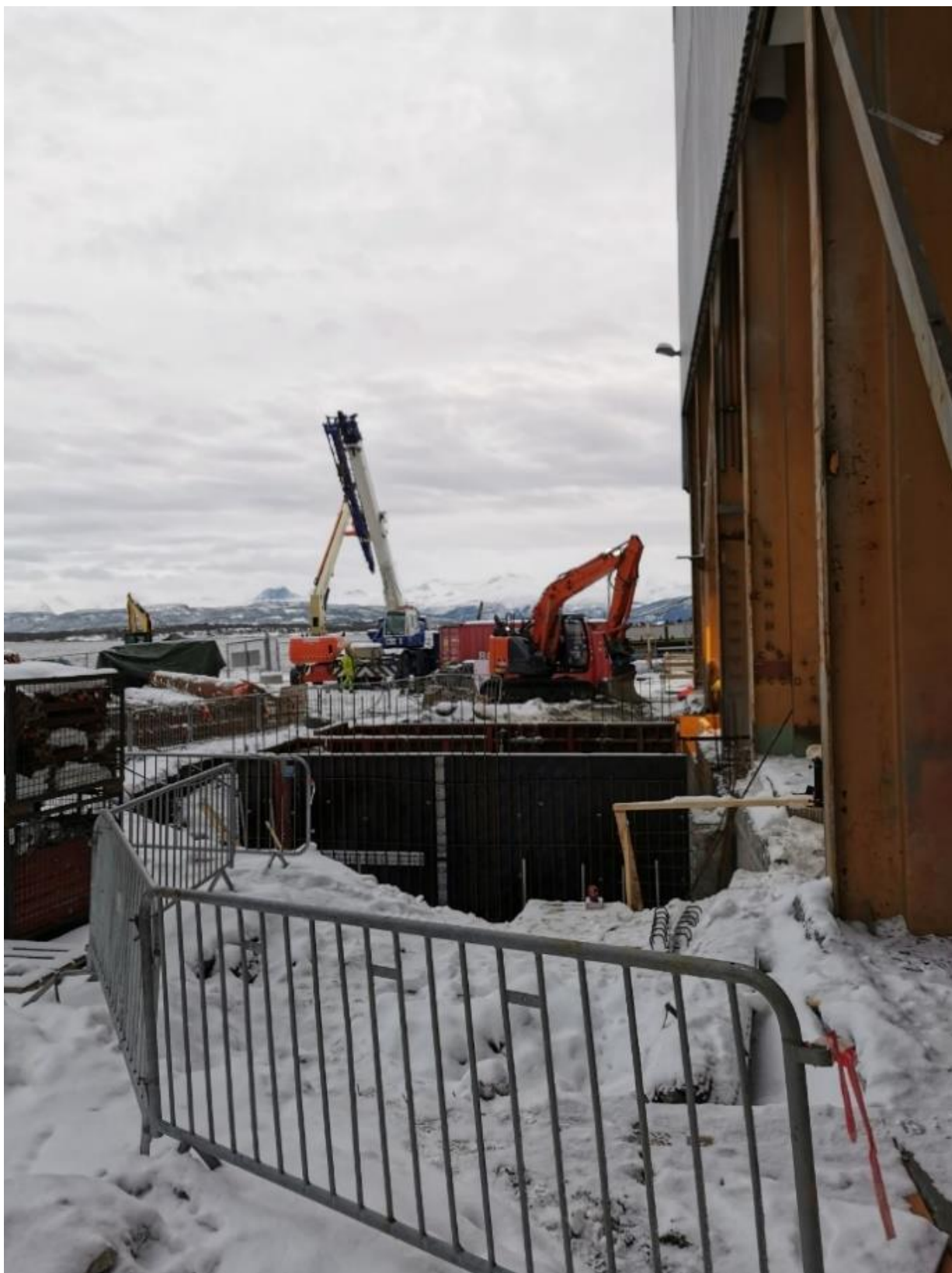
Figur 30 Den påbegynte heissjakta som forskales ved bruk av Peri kasettsystem
