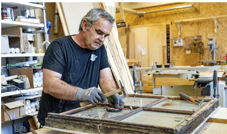
Figur 18: Antikvarisk rehabilitering av vindu. hentet fra: glassogfasade.no
