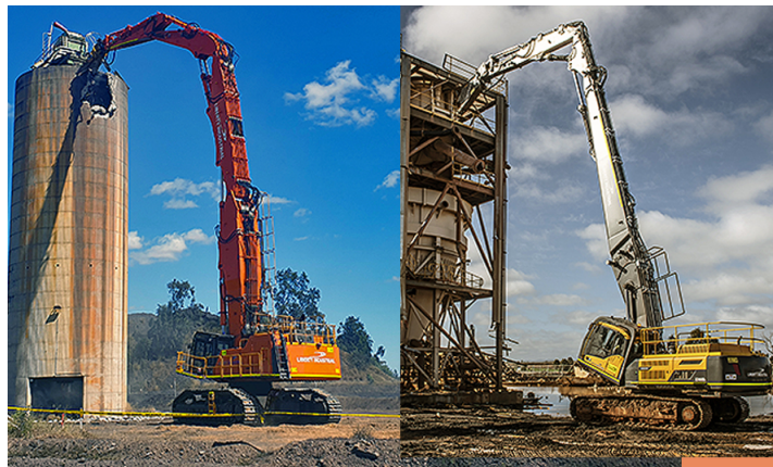
Figur 14: Stålkutter hentet fra buildaustralia.com
