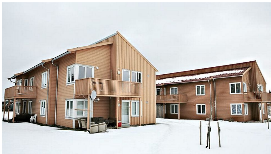
Figur 6: De to husene i pilotprosjektet, hentet fra: adresa.no
