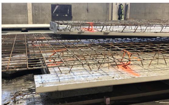
Figur 24: Vegg under produksjon
