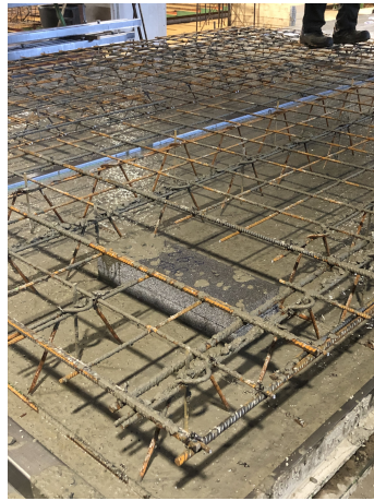
Figur 26: Støp av forskalingskive
