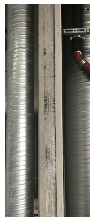
Figur 13: Con-Form vegg ferdig støpt Nidarvoll
