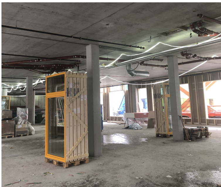
Figur 15: Nidarvoll - Rehab.bygg inne
