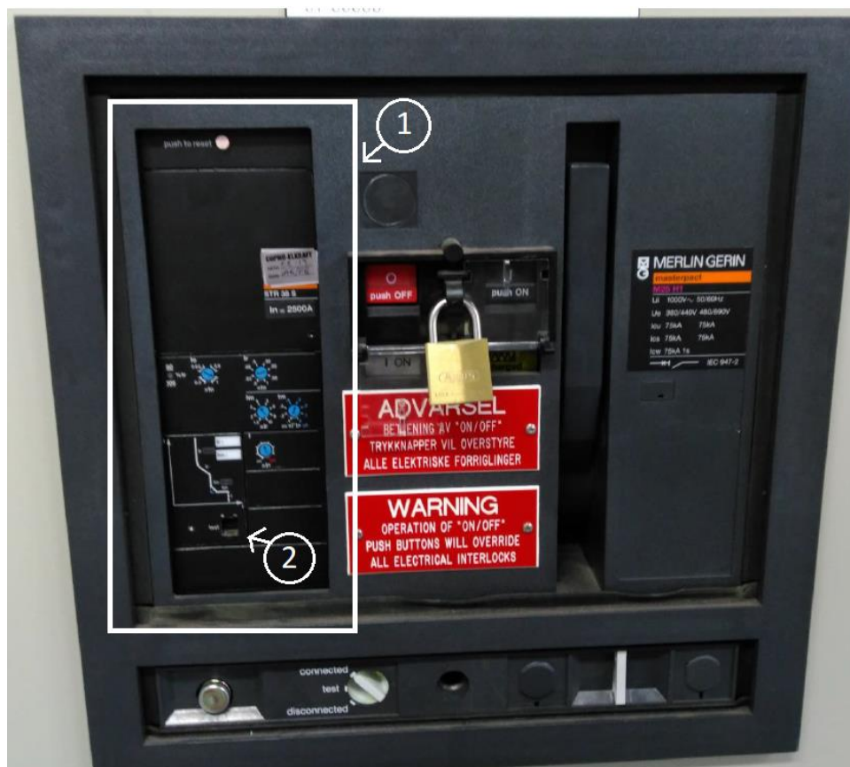
Figur 6-11: Merlin Gerin masterpact 690V hovedbryter/effektbryter med innebygd relèvern.
