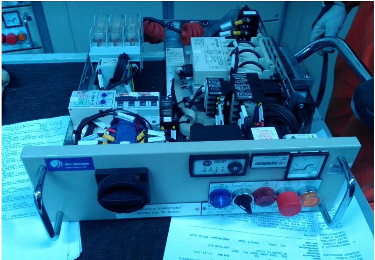
Figur 6-16: Starterskuff for kraftkrevende forbrukere.
