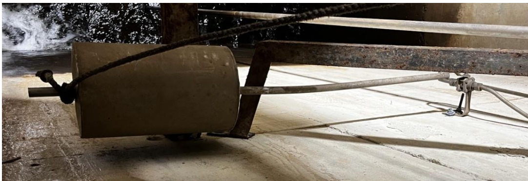
Figur 22 - Ejektorflottør lensekum
