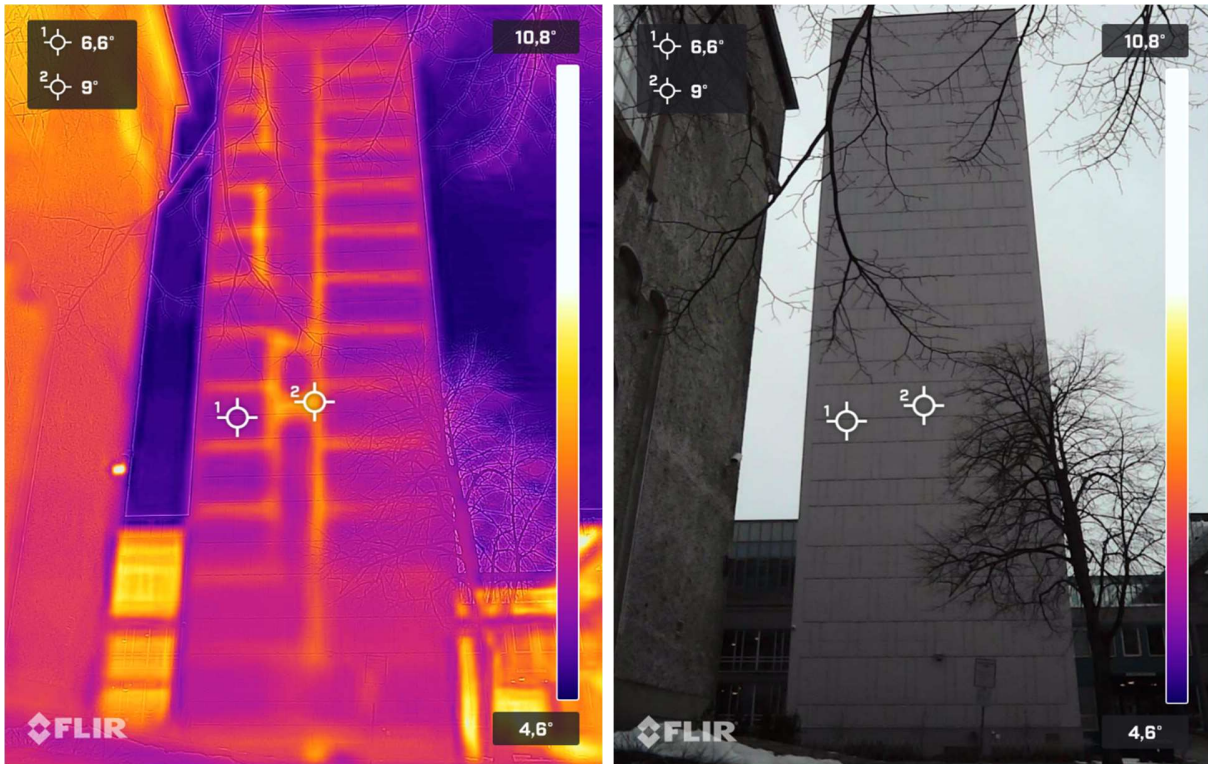
Bilete 16: Termografi av austleg fasade på S2
