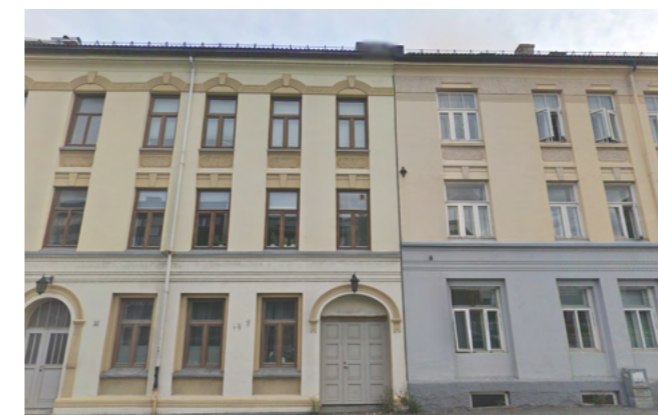
Eksempel på bygård i mur, Elgesetergate 45 og 47. Her ser man markert sokkel, ornamenterte trykkbuer med læsestein, detaljert dør til portrom og lister som markerer etasjeskiller. Grunnmur er uttrykket og markert med list eller tekstur.
