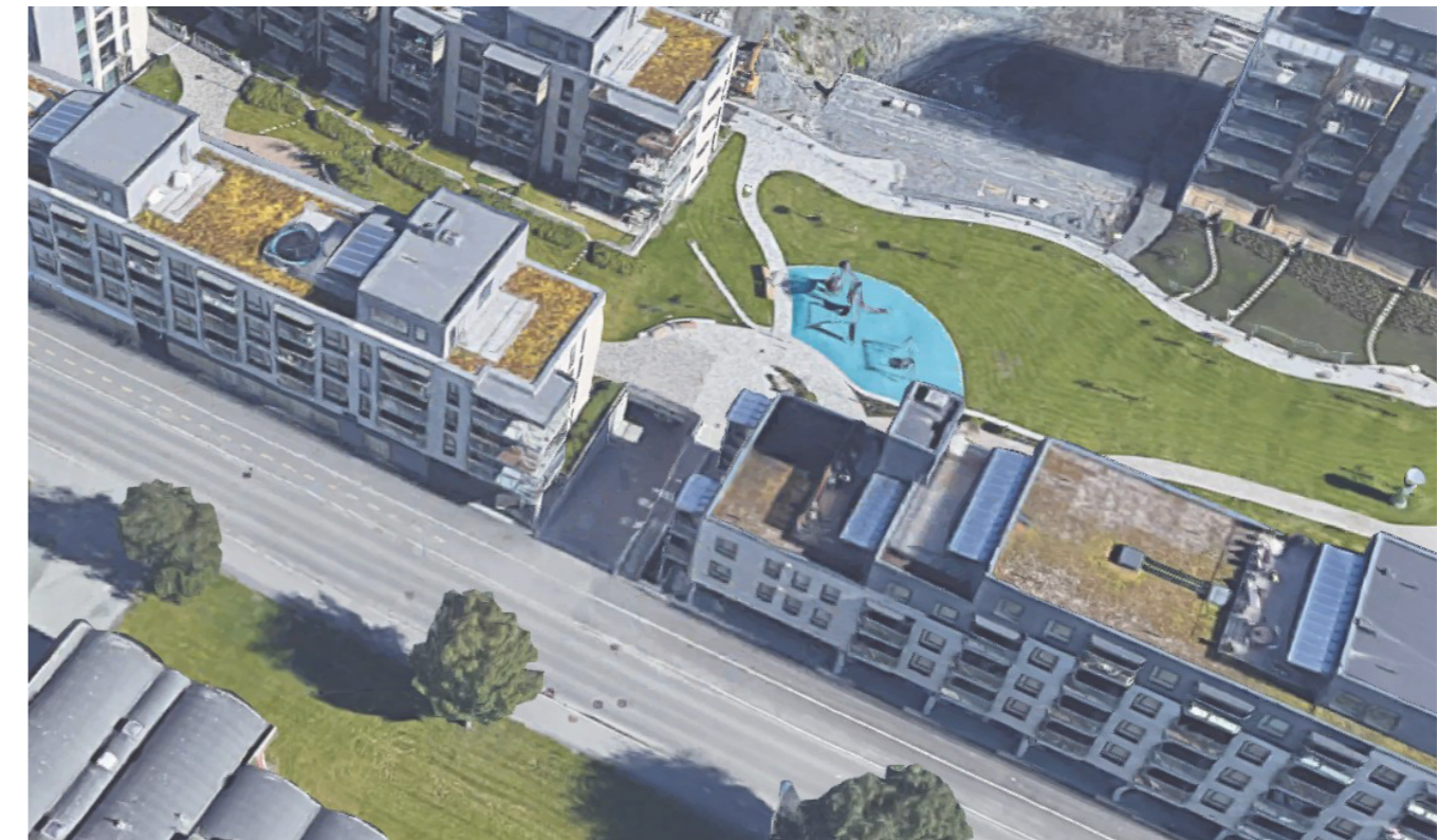
Mose på flate takflater sørger for overvannshåndtering.
