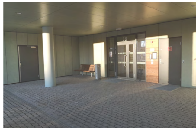
Nedsunket inngangsparti med dør til sykkelbod og teknisk rom
