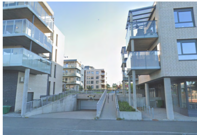
Nedkjøring til parkeringskjeller med sykkelparkering til venstre
