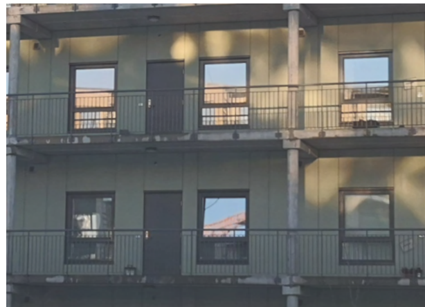
Store vinduer inn til soverom fra felles svalgang
