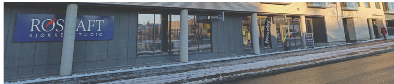
Første etasje med skilt og vindu bak søyle
