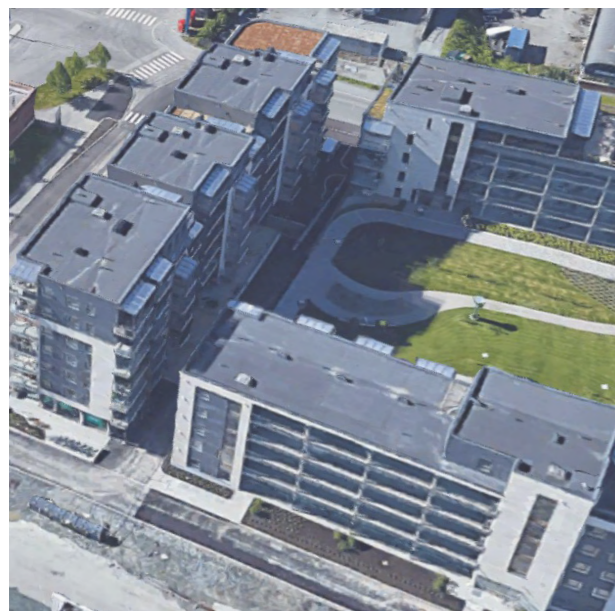
Glippe mellom bygninger for å hindre brannspredning, eller for å kunne komme til med brannbil
