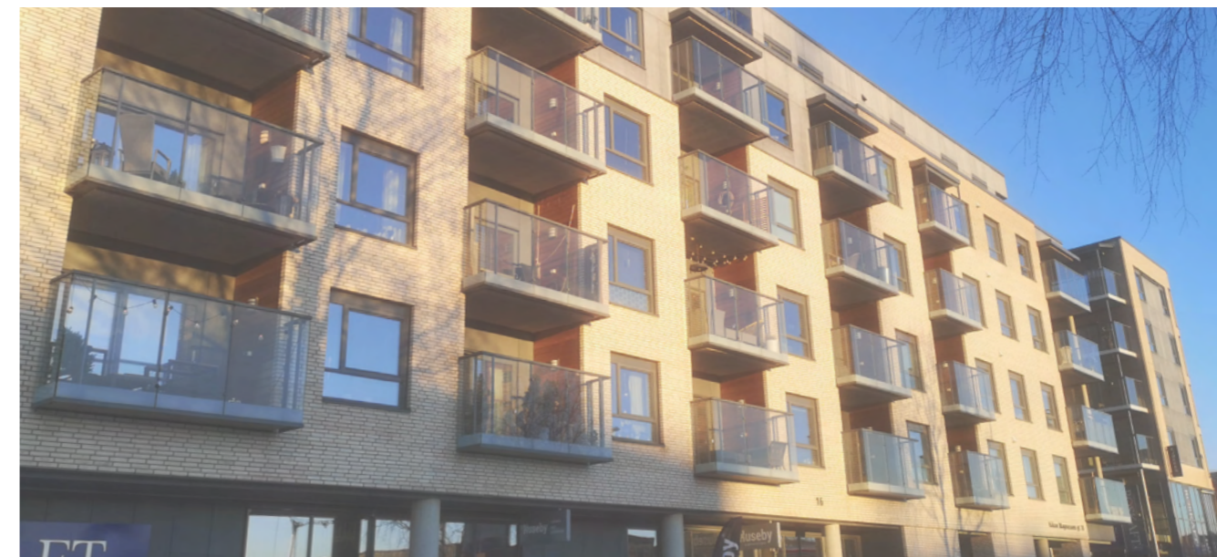
Dype balkonger med høyt glassrekkverk ut mot trafikkert vei
