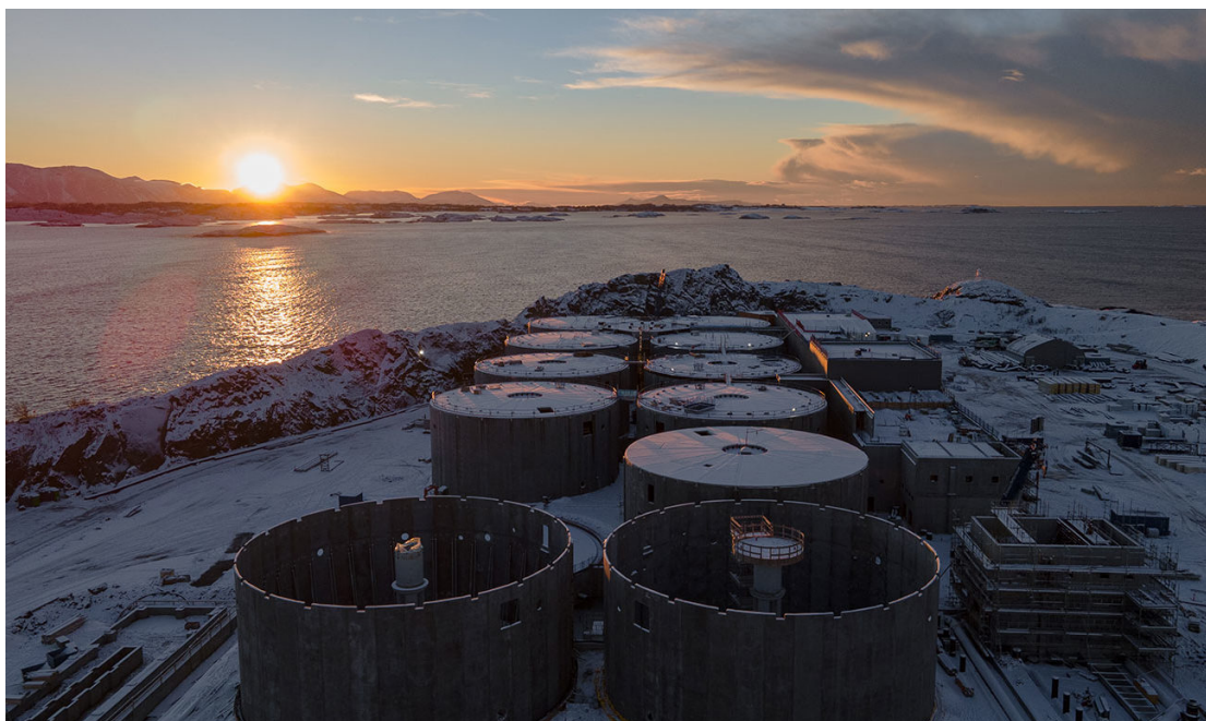
Figur 1.1: Det landbaserte anlegget på Indre Harøya [2]
