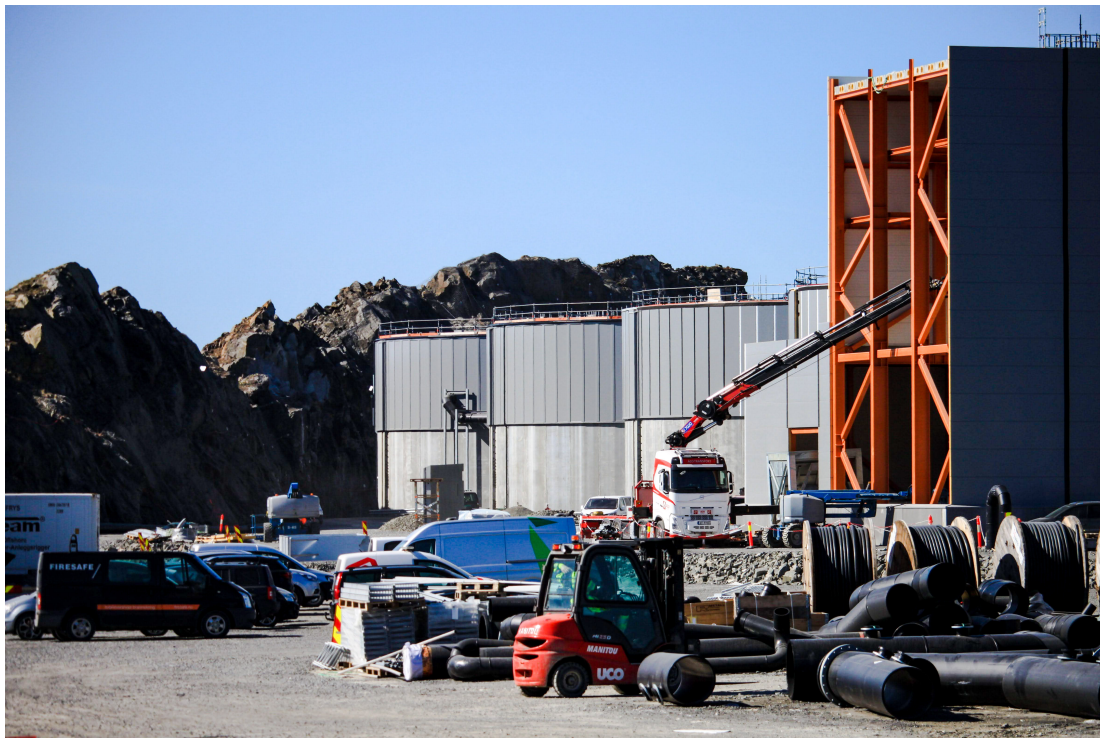
Figur 3.1: Anlegget under konstruksjon.
