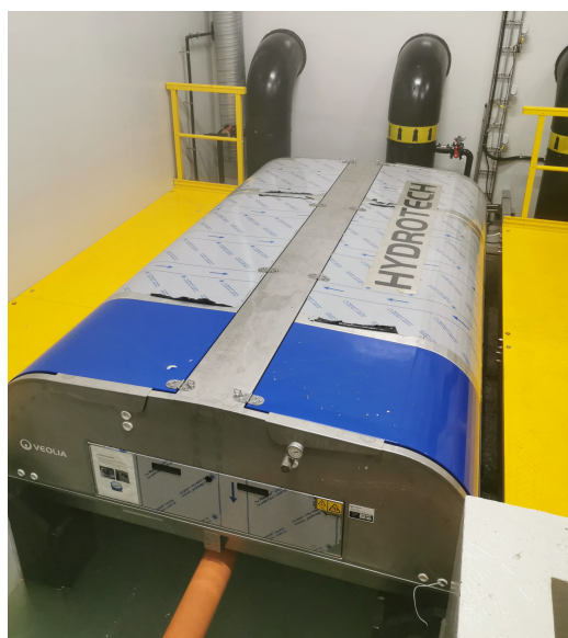
Figur 4.1: Trommelfilter levert av Hydrotech.
