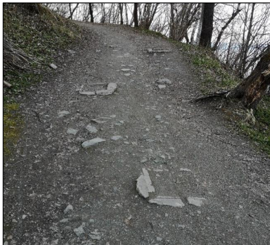
Figur 69: Veien opp til batteriet med firkantede betongfundamenter for det som trolig har vært betongsperrer. Foto: Kristoffer Eliassen Grini
