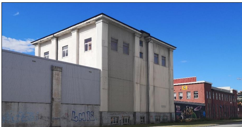
Figur 41: Sentralkjelhuset i hvit kledning. Foto: Kristoffer Eliassen Grini
