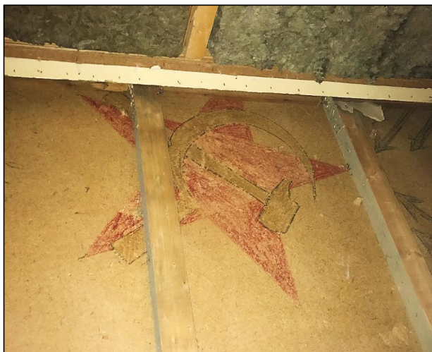
Figur 14: Veggen bak kledningen inne i en boenhet i Strindheim hageby 2018. Foto eid av Per Håkon Meland.
