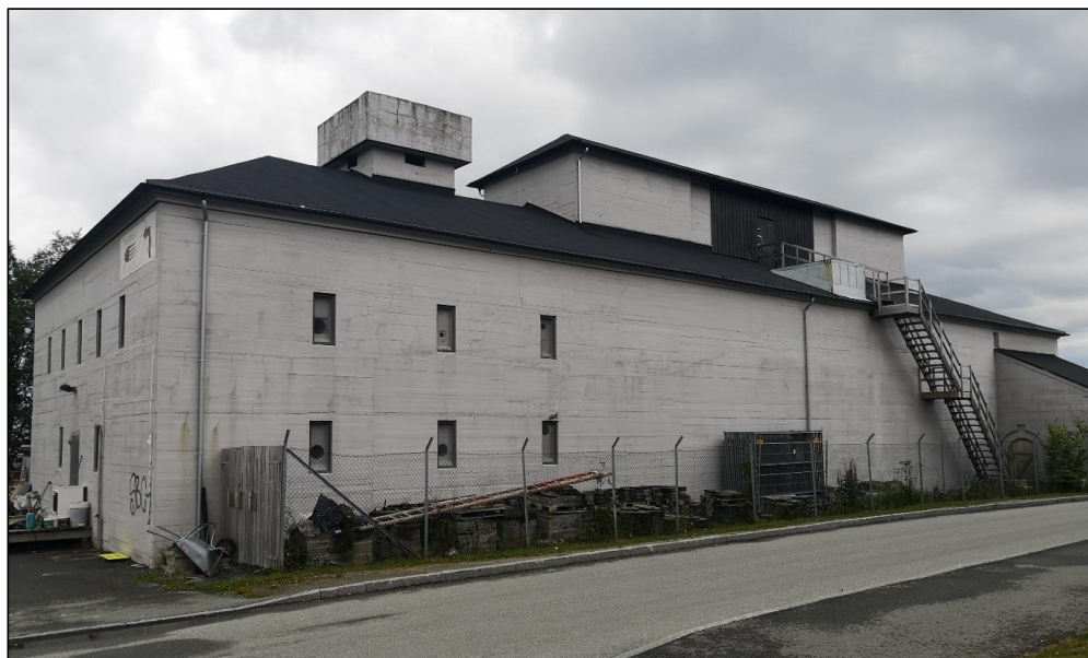
Figur 98: Proviantbunkereren, tatt mot øst. Observasjonstårnet til venstre; de to tårnene til høyre som er dekket av tak, var under krigen flakstillinger for lett luftvern. Foto Kristoffer Eliassen Grini
