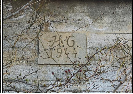
Figur 76: Betongplakett over inngangen. «H. G. 1944». Foto: Kristoffer Eliassen Grini
