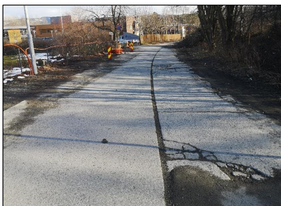
Figur 65: Betongplater i et bevart strekke av taksebanen. Foto: Kristoffer Eliassen Grini
