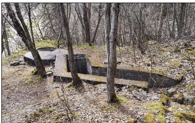
Figur 78: En Ringstand av betong med støpt nedgangsparti. Foto: Kristoffer Eliassen Grini
