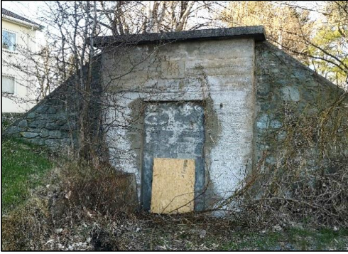
Figur 77: Betongportal, nedgang til underjordisk bunker. Foto: Kristoffer Eliassen Grini
