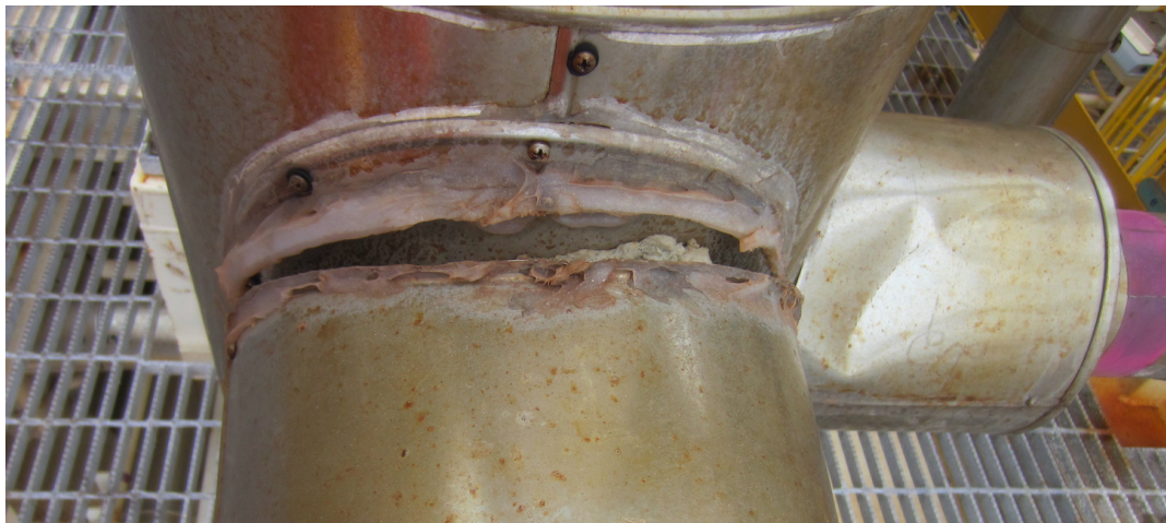
Figur 3.3: En tydelig skadet ytterkapsling der vann og forurensning kan trenge inn til isolasjonen Eddysonics, ud
