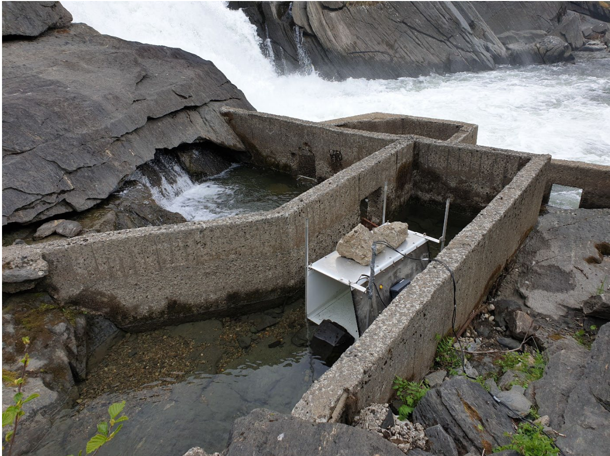
Bilde: Plassering av videotunellen i fisketrappa i Drevja. I forkant av videotunellen ble det montert et ledegerde slik at fisken ikke kan passere utenom. Foto: Aslak Darre Sjursen
