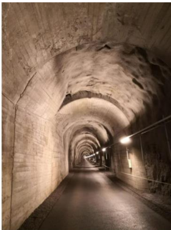
Figur 20.: Betongutstøyping i Bogna Kraftverk. Fotograf: Thomas Stormoen.
