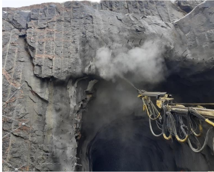
Figur 17: Sprøytebetong blir påført påhugg vest på Bruliheitunnelen.
