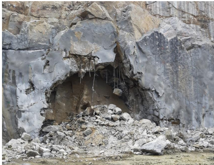
Figur 51: Utfall av kile ved påhogget til Bruliheitunnelen.
