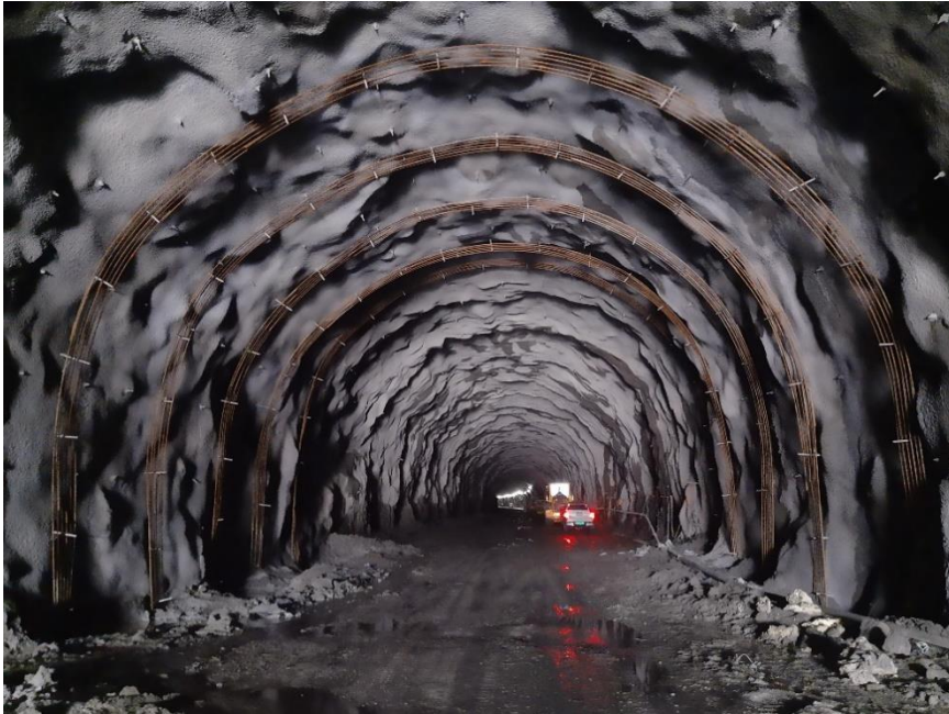
Figur 19: Armeringa i dei armerte sprøytebetongbogane.
