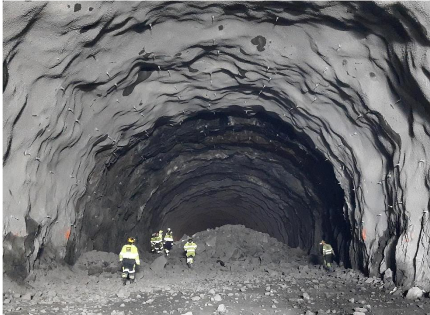
Figur 16: Eksempel på systematisk bolting.
