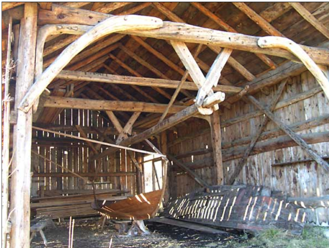
Båtskot bygd som grindverksbygg. Sunnmøre museum, Ålesund.
