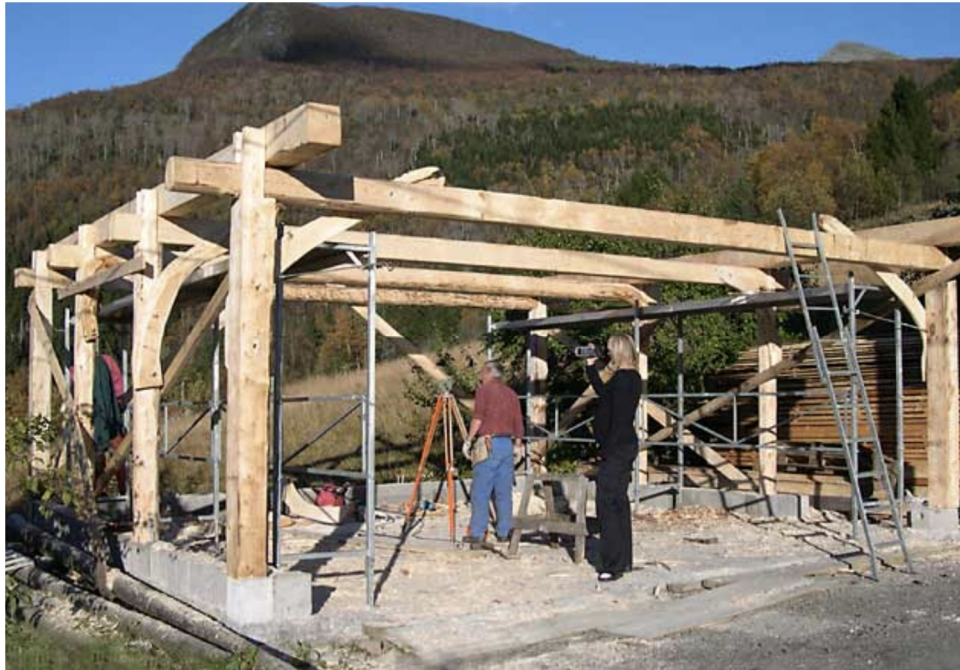
Figur 2-4 Grindene er satt opp og rafthaljene lagt på plass.
