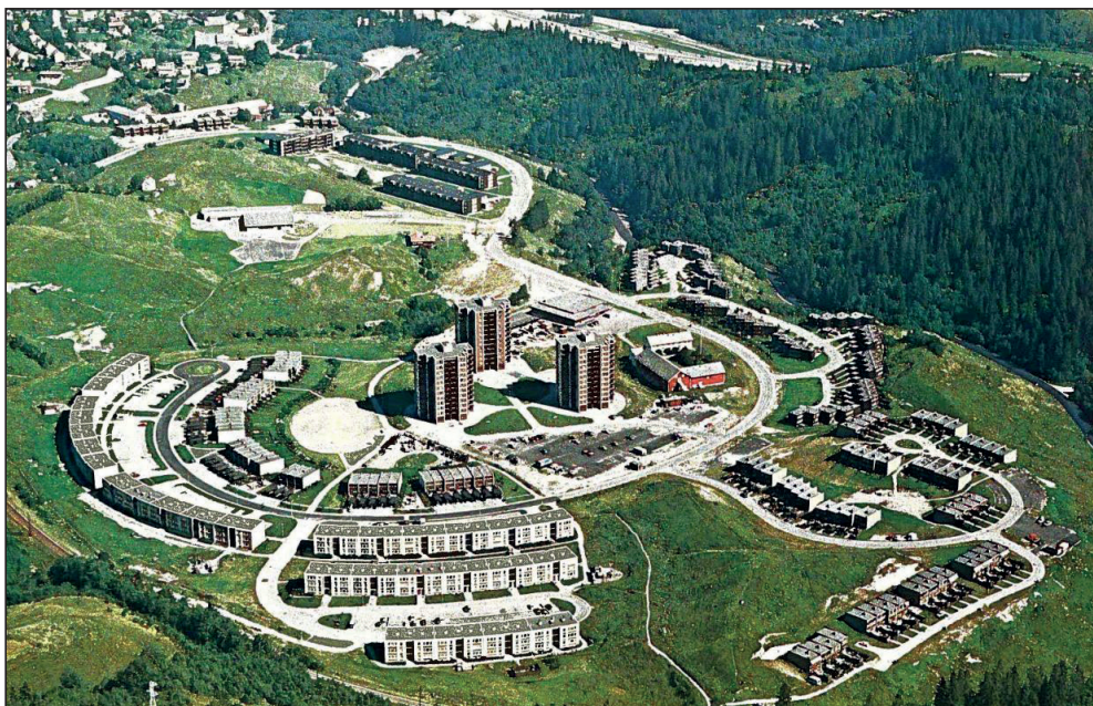
Figur 29: Romolslia som helt fersk drabantby i 1977, fotografert mot nord. Øverst mot venstre ser vi Flatåsaunet BL med fire treetasjes blokker. Barneskolen, som ligger sørvest for Flatåsaunet, ble tatt i bruk i 1976 og da sto butikkanlegget også ferdig. I forgrunnen ser vi Romolslia BL, med høyblokker, rekkehus og treetasjes blokker. Butikken ligger like nord for den gamle gårdsbebyggelsen. Kilde: Fjellanger Widerøe AS.
