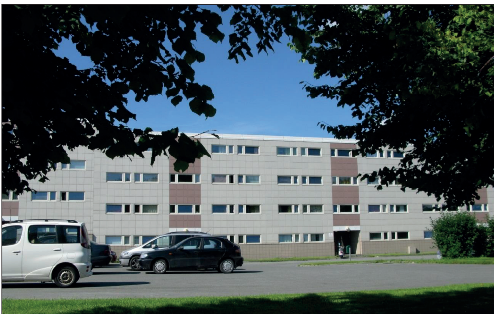
Figur 30: Fasade på blokk i Flatåsaunet BL. Foto: Hilde N. Rørtveit.
