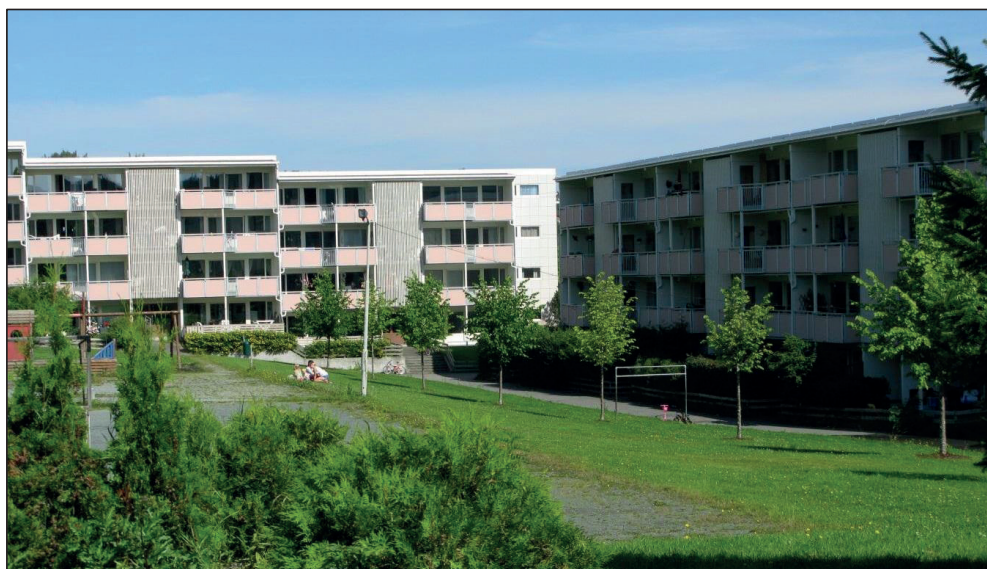
Figur 31: Baksiden av blokker i Flatåsaunet BL, med lekeplass og friområde. Foto: Hilde N. Rørtveit.
