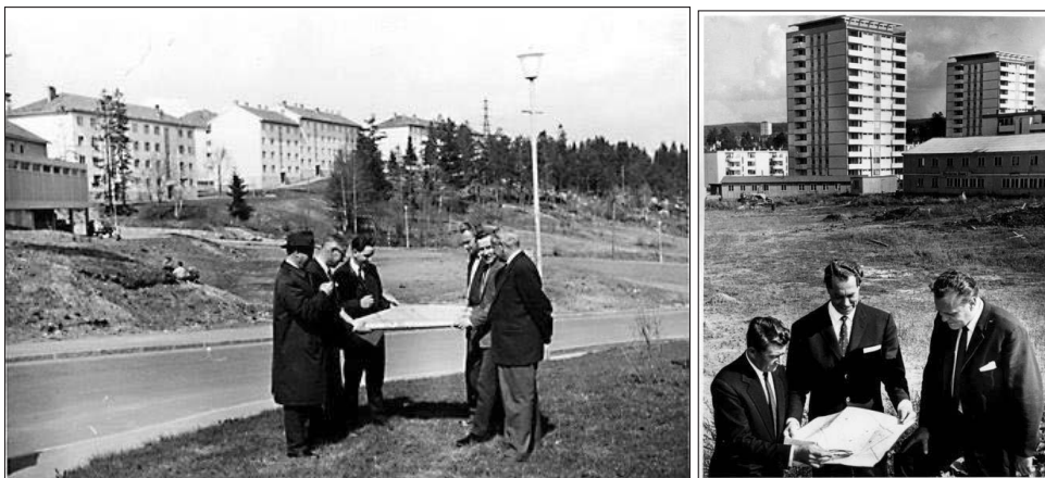
Figur 10: Drabantbyer i 1950-talls- og 1960-talls arkitektur. Bilde t.v.: Lambertseter i Oslo, Norges første drabantby, ble regulert og tegnet for Oslo og Omegn Sparelag (OBOS) av Frode Rinnan rundt 1950. Her sammen med OBOS-sjefene på befaring. Bilde t.h.: Befaring på Manglerud i Oslo tidlig på 1960-tallet. Kilde: OBOS bildearkiv.
