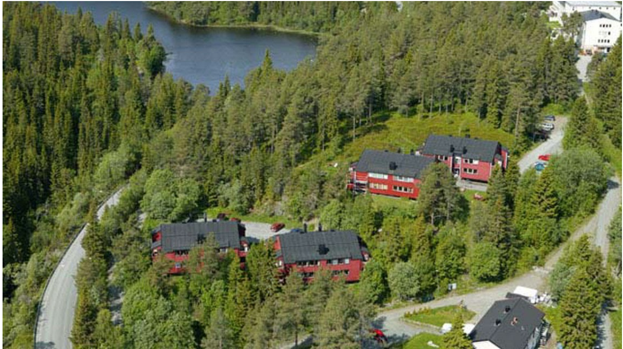
Figur 19: Oversiktsbilde av Kystadåsen Borettslag (TOBB, u.å)
