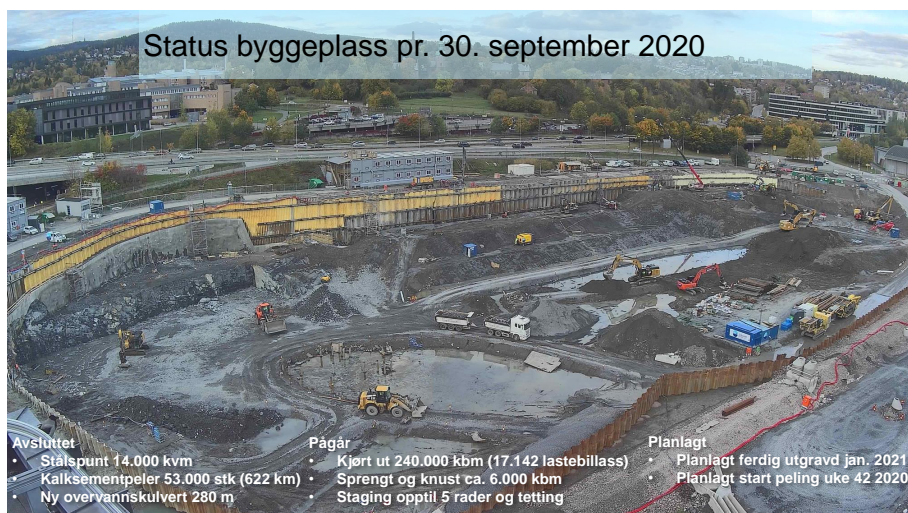
Figur 4.6: Eksempel på ryddig byggeplass i prosjektet Livsvitenskap (Holm, 2021)
