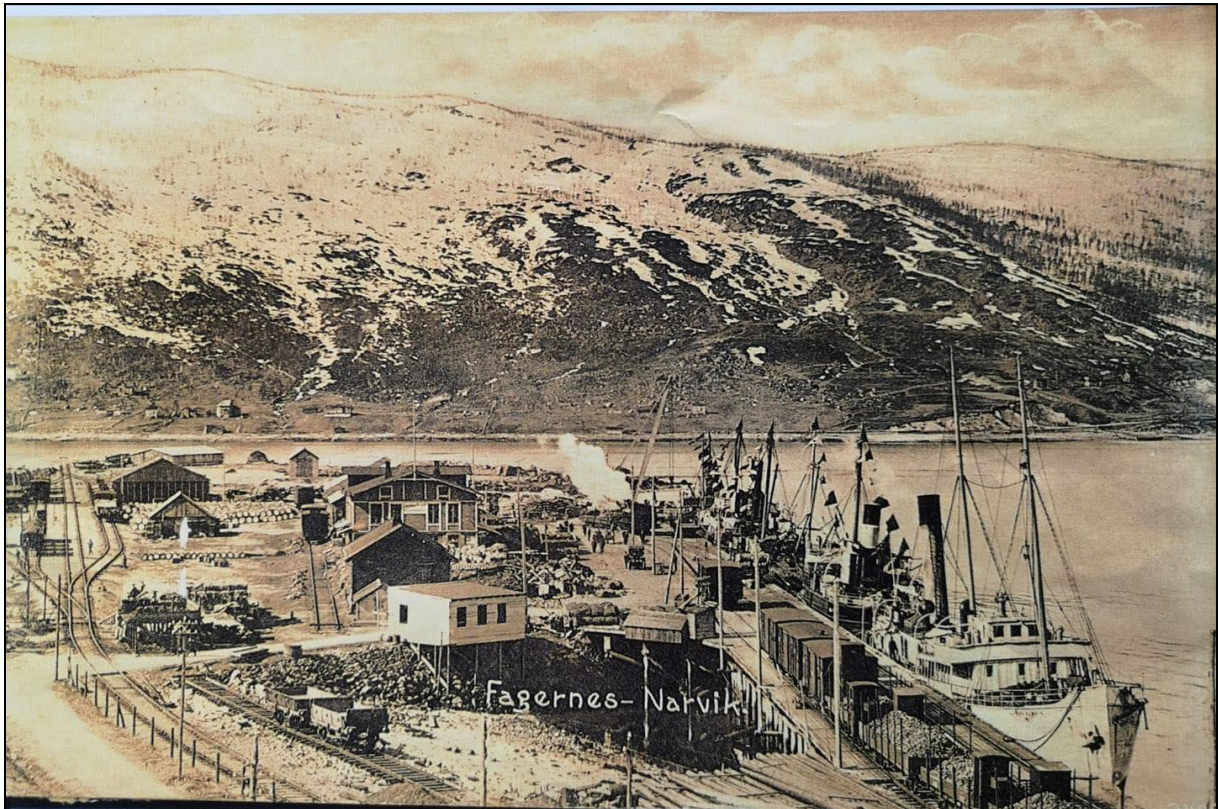
Figur 6: Både i kapasitet og kvalitet var Statens havneanlegg på Fagernes bedre enn Kleiva. Her vises dampskip som la til fordi Havnevesenets dampskipskai var full. Det lå likevel et stykke unna byen, men kunne nås med jernbanen som synes på bildet. Året er antatt å være ca. 1915. 113
