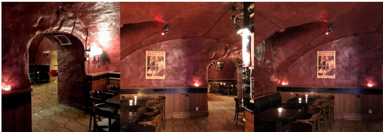
Eksempel fra Kjøpmannsgata 50 på usentrert dør. På bildet til venstre ser vi også rester etter gamle hengselfester. Bildet er tatt fra hovedrom inn mot forrommet. Foto: Christina Wærøy-Lund
