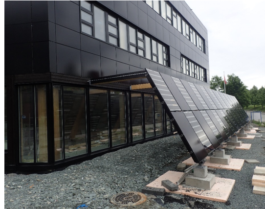
Ferdig montert BIPV på sørfasade og pergola før ferdigstilling av utomhusarbeid
