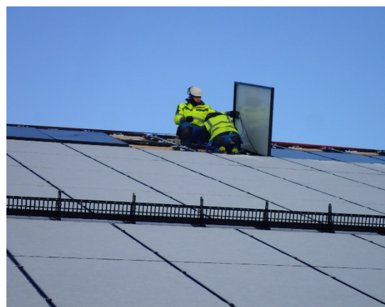
Figur 16. Montering av solcellepanelene på taket av ZEB-laboratoriet ble gjort vinteren 2019/2020 slik at vi kunne starte høsting av solenergi i slutten av april – et halvt år før bygget var ferdig.
