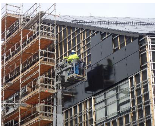
Innfesting av solcellepaneler på vestfasade
