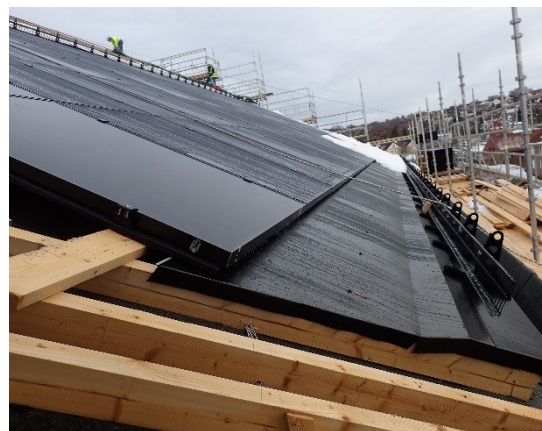
Avslutning av beslag under solcellepaneler
