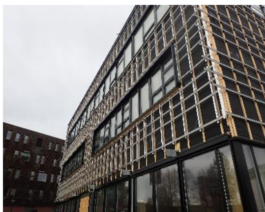
Oppbygning av luftespalte bak solcellekledning på sør- og østfasade. Innerste lekt er brannimpregnert trevirke.
