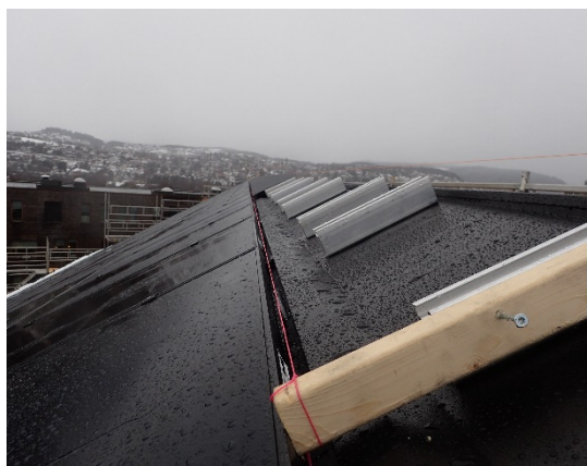
Beslag montert som ekstra fuktsikring under dummy-panel ved møne. Øverste rekke med solcellepanel er vist til venstre i bildet.
