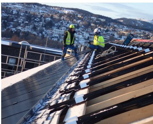
Figur 16. Montering av solcellepanelene på taket av ZEB-laboratoriet ble gjort vinteren 2019/2020 slik at vi kunne starte høsting av solenergi i slutten av april – et halvt år før bygget var ferdig.
