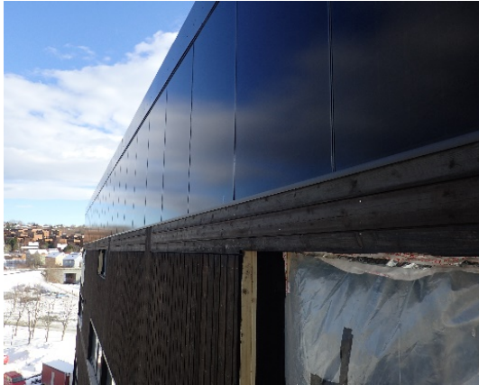
Ferdig montert BIPV på nordfasade
