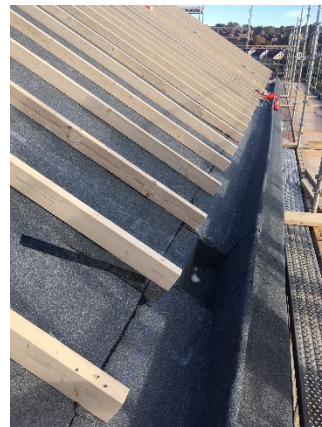
Nedfelt "varm" takrenne ved takfot
