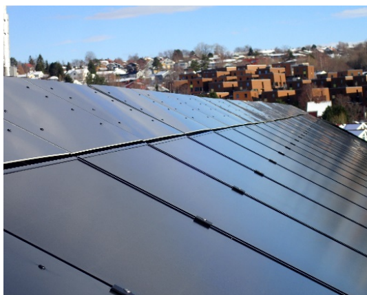
Ferdig BIPV på tak. Øverste platerække er dummy-paneler.
