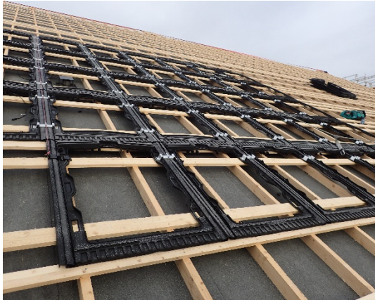
Kassettsystem for montering av solcellepaneler på taket
