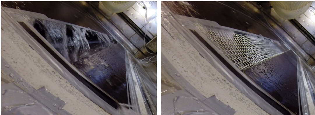
Figur 6. Kraftige regnskyll på glatt taktekning gir mye vann som renner i stor fart nedover taket. Med for smal takrenneåpning vil ikke vannet bli fanget av takrenna. Bruk av rist kan lede vannet ned i renna og samtidig hindre at løv blokkerer taknedløpene [27].
