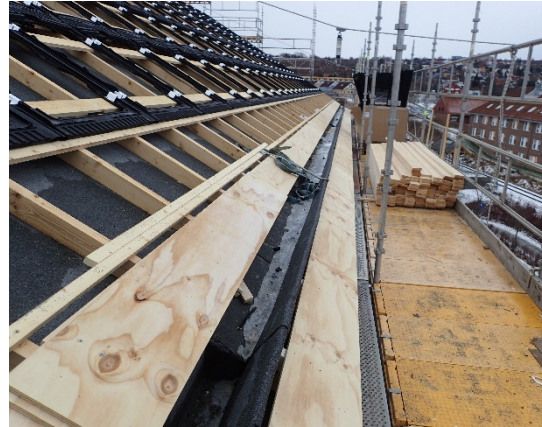
Underlag for innfesting av snøfanger ved takfot
