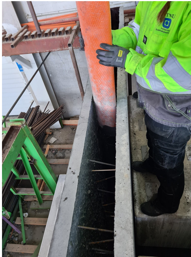
Bilde 11.3.1: Fra pumping av senterbetongen inn mellom vangebetongene.
