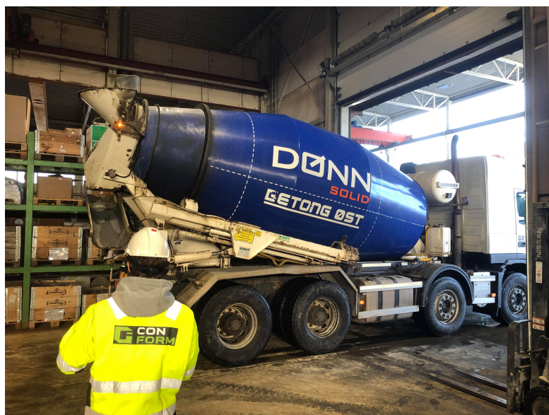
Bilde 3.3.1: Betongbil brukt til prøveblanding hos Betong Øst.
