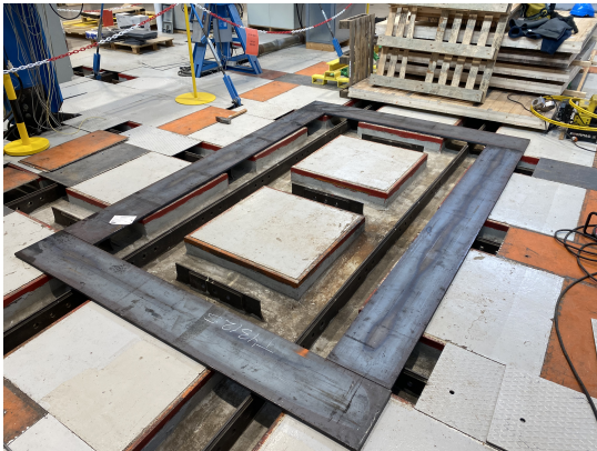
(a) Stålrammen hvilende på betonggulv.
