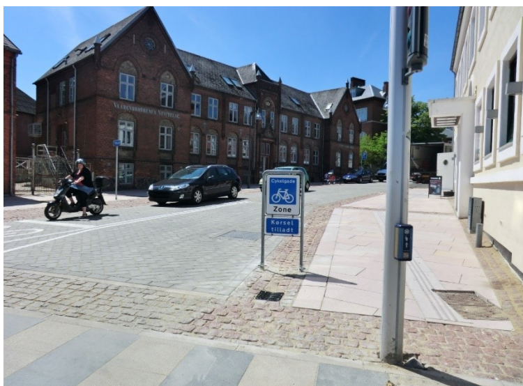
Figur 34: Kjørebane og fortau er ikke skilt med en kantsteinsforhøyning, men rennesonen på 0,75 meter har en liten fordypning. Skilt og rist er plassert i rennesonen. Overgangen mot krysset er markert med ca. syv rader med brostein innrammet av en annen type belegningstein.
