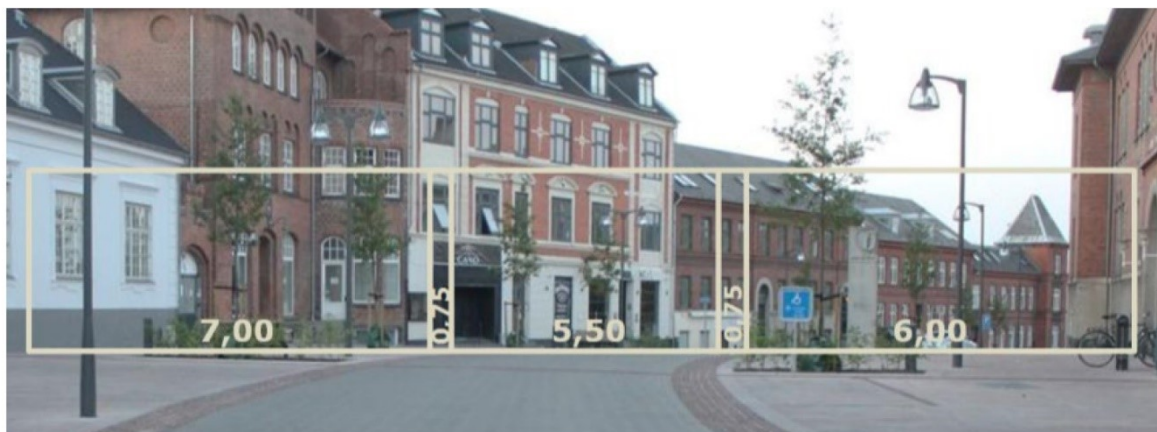
Figur 33: Gatetverrsnitt for Jernbanegade. Kjørebanelen (eksklusiv siderabatter) utgjør 5,5 meter av den totale bredden på 20 meter. Resterende deler er benyttet til fortau (7 og 6 meter) og vannrenner (0,75 meter). Figur: Vejregelgruppen Byernes trafikarealer (2019)
