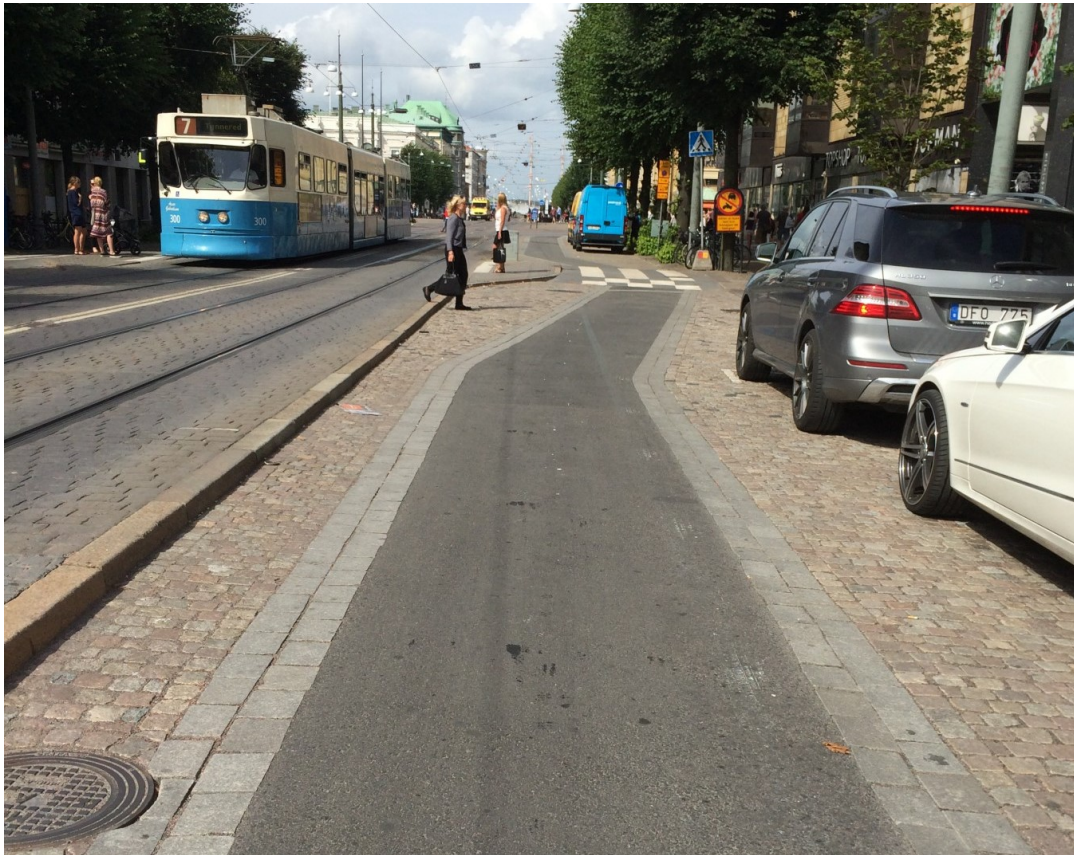
Figur 37: Selve kjørebanelen er ca. 3,2 meter hvorav asfaltstripen i midten er 1,5 meter. Det ikke markert en ytre grense i parkeringens lengderetning, men oppmerking i underlaget i parkeringens bredderetning (til høyre i bildet) viser nærmeste lovlig parkeringsavstand til fotgjengerovergang. Foto: Jennie Fasth
