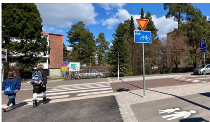
Figur 22: Syklister som kommer fra tilgrensede sykkelinfrastruktur får egne skilt som viser at de sykler inn på en sykkelgate, samt de at de har vikeplikt ved systemskiftet. Bildet er, i likhet med figuren over, fra Brändö Parkväg. Foto: VM Suomalainen Oy
