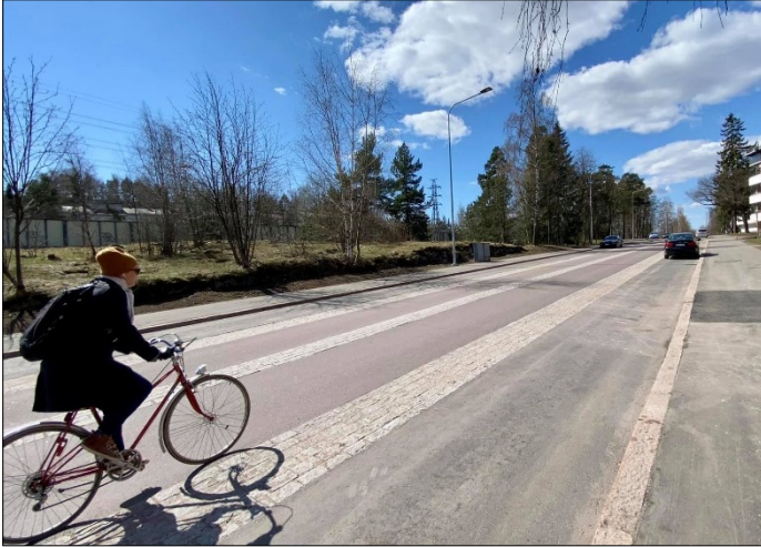
Figur 41: Brändö parkväg er toveisregulert, og en steinsatt midtrabatt deler kjørebanelen i to felt. Langs deler av gaten er det parkeringslommer på begge sider av gaten. Disse er skilt fra kjørefeltene med brostein i 6 rader. Foto: VM Suomalainen Oy
