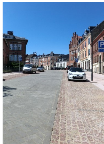
Figur 35: Underlaget i parkeringssonen er det samme materialet som vannrennen, men brosteinene i parkeringssonen er lagt i et annet mønster. Parkeringsplassene blir avskilt i parallell retning med en rad med sort brostein. Sammen markerer disse en sikkerhetssone til parkerte biler. Foto: Lárus Ágústsson | COWI
