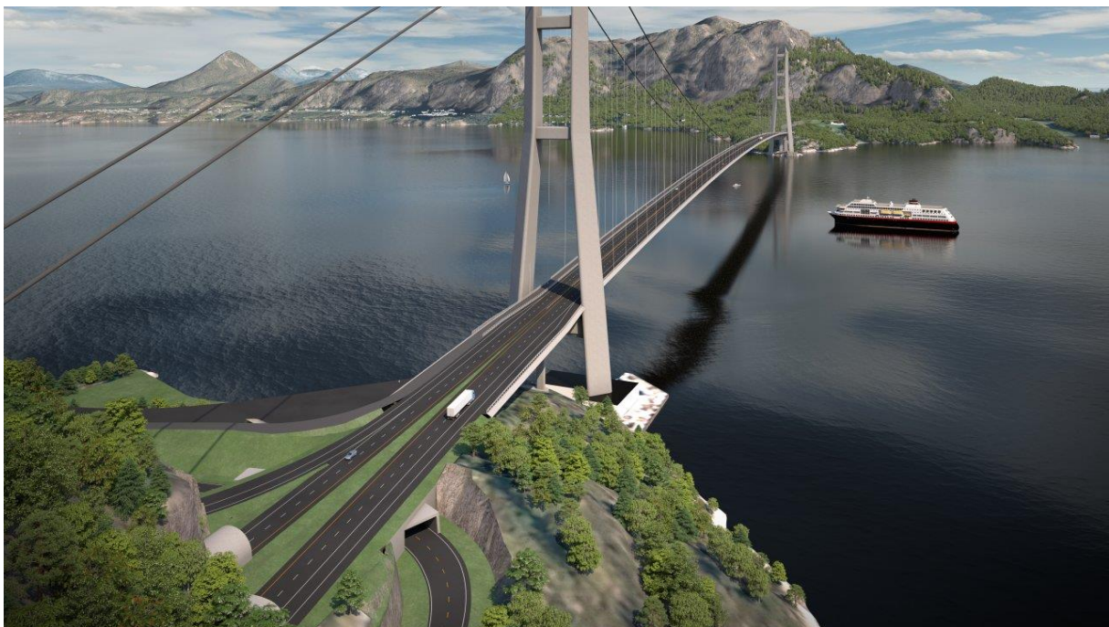
Figur 13: Bru over Julsundet (Statens Vegvesen, 2020)
