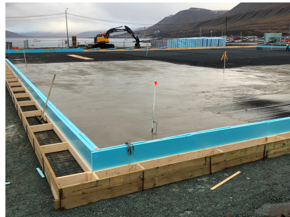
(d) 30.09.2020; casting of concrete slab.
