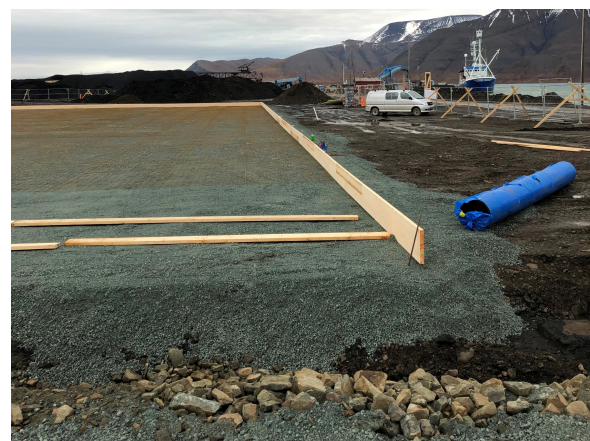
(d) 23.08.2020; placement of reinforcement on gravel layer.
