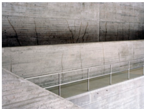
De røffe betongoverflatene.
