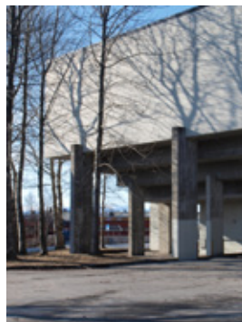
Betongen som bretter seg.
