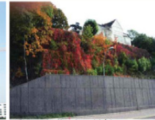
142) Mossveien: klatreplanter i skrånning
