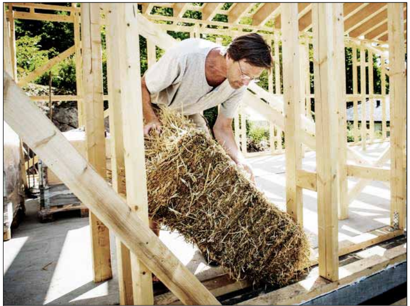
11) Arkitekt Rolf Jacobsen i aksjon under byggefasesen på Ormelet Studiobygg Tjøme. Her er arkitekten involvert "hands-on" i byggingen, og fungerer som mentor for tilreisende som søker mer kunnskap og kompetanse på Halmbygging.
