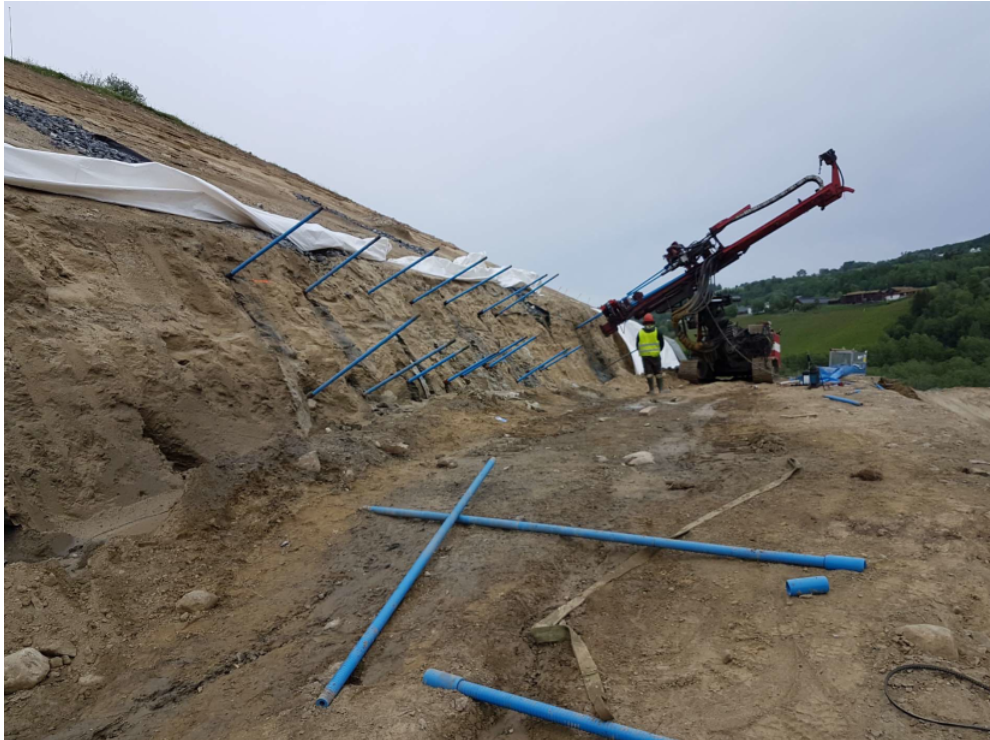
Figur 6.2: Installering av jordnagler i Soknedal (Bilde fra Sweco).
