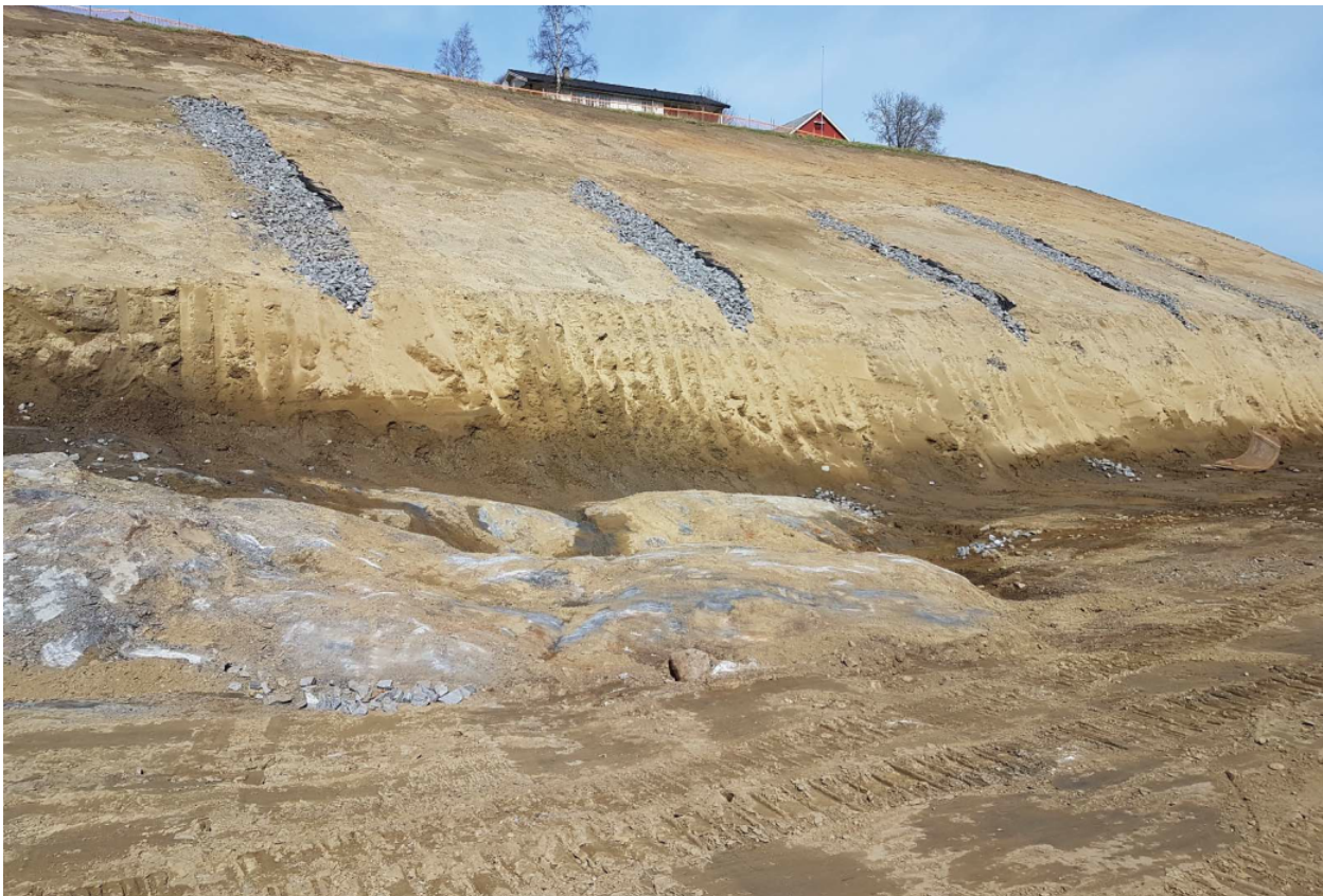
Figur 6.4: Berg i dagen fra utgravning til første nivå og stedlige masser i området i Soknedal (Bilde tatt av Sweco).
