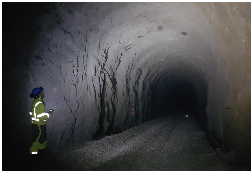
Figur 41 Små vanddrypp fra hengen følger tunnelkonturen i gammelt tunnellop.
