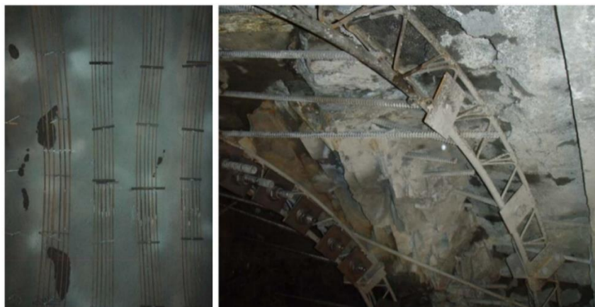
Figur 11 T.v. Konvensjonelle armerte sprøytebetongbuer (RRS). T.h. Prefabrikerte gitterbuer (Statens Vegvesen, 2008). Fotografiene er tatt før buene ble tildekket av sprøytebetong
