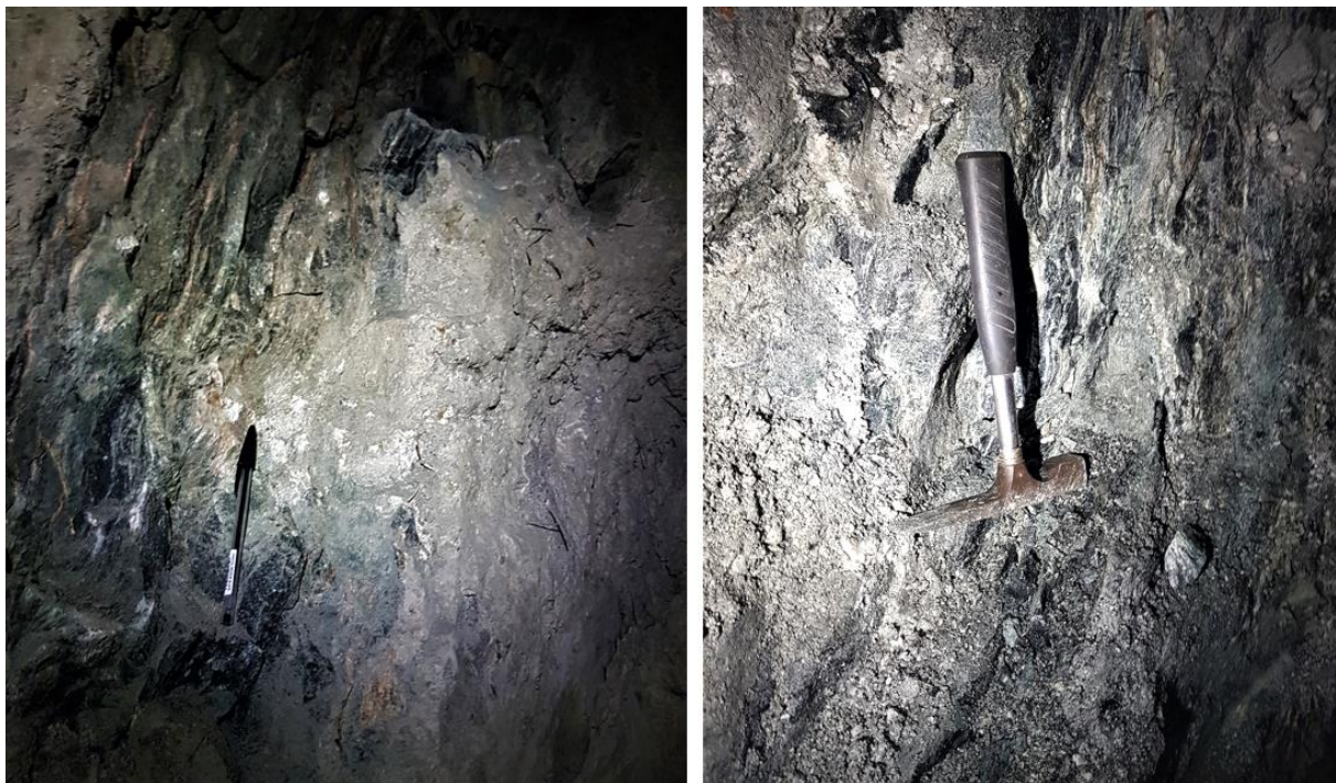
Figur 39 Fotografi av bergmassen i svakhetssonen. Bildet er tatt i koplingssporet ved bergstaben mot N2.
