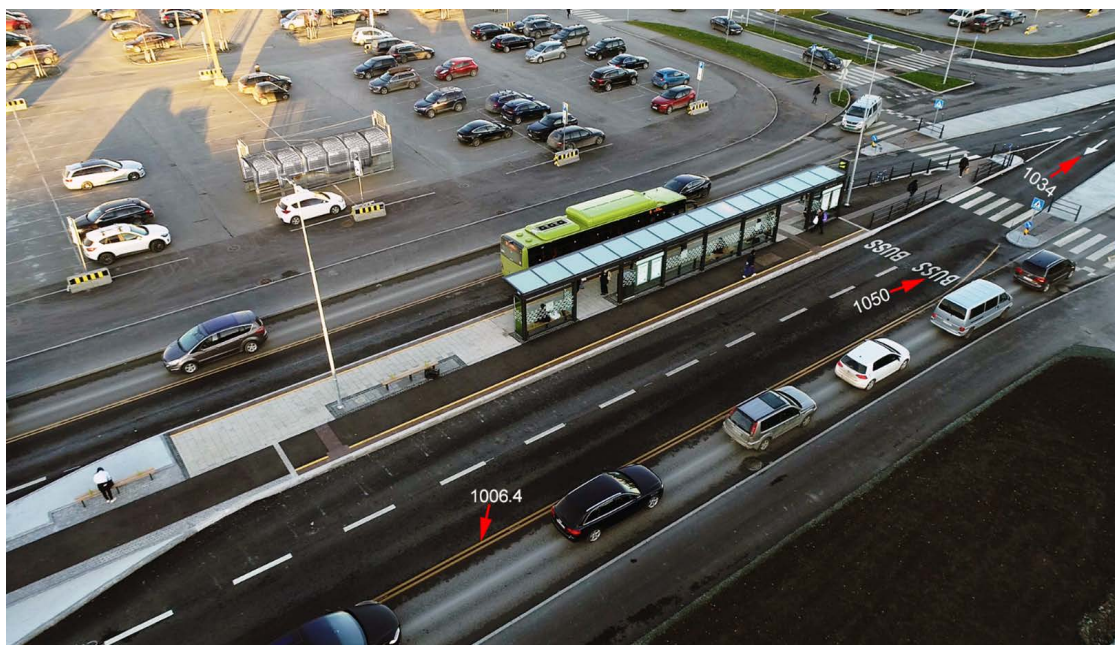
Figur 53 viser ekstraordinær nødvendig vegoppmerking i Anne-Kath. Parows Veg på grunn av at holdeplassen er utformet med midtstilt plattform (Foto: Asplan Viak).
