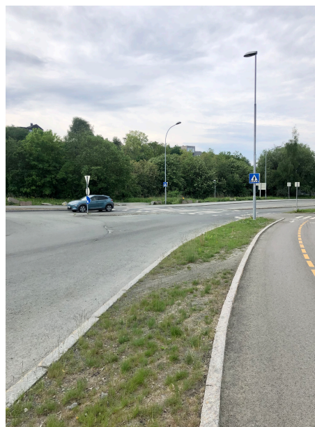
(b) Bilde tatt i retning Strindvegen vest.
