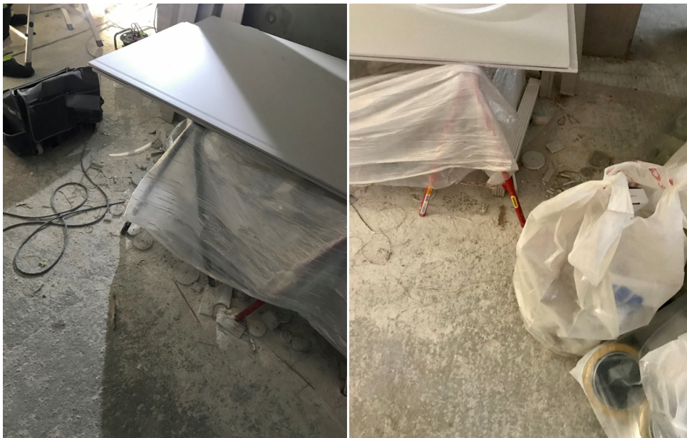
Figur 6.7: Arbeidsstasjon med gipsing (eget bilde).
