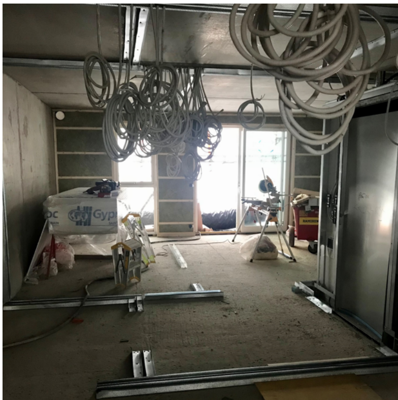
Figur 6.4: Område hvor topp- og bunnsviller er montert (eget bilde).
