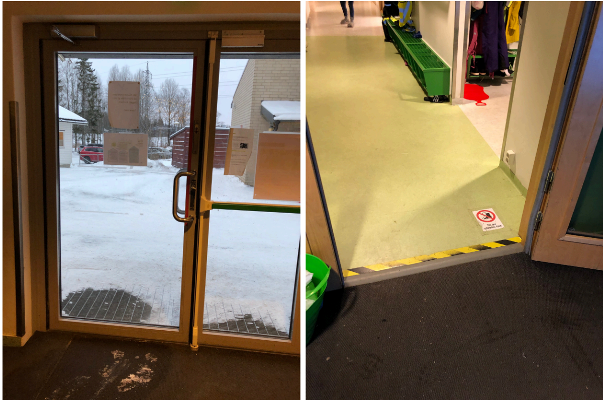
Figur 31: Inngangsparti i hovedbygning på Skole B
