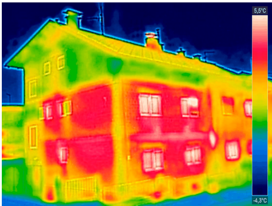
Figur 4: Synlige temperaturforskjeller ved termografering (Termografi Teknikk, 2020)
