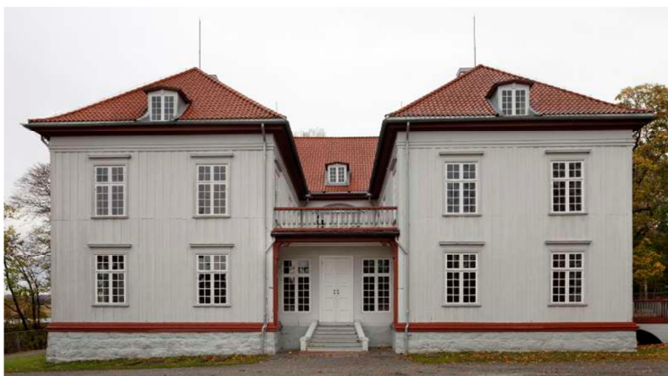
Figur 4: Eidsvollsbbygningen, fasade vest (Statsbygg)
