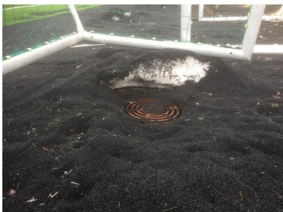
Figur 3: SBR brøytet av bane sammen med snø. Granulatet er plassert over et kumlokk som fører dette med seg videre og bidrar til spredning av mikroplast [7].
