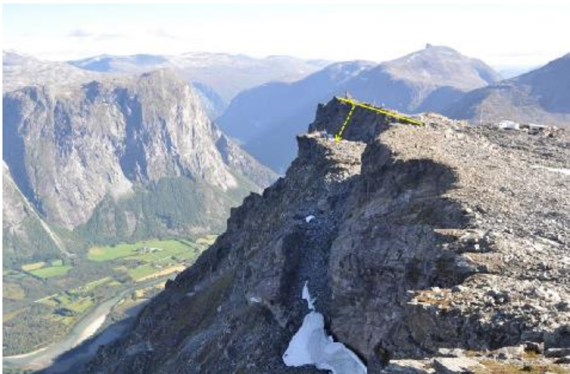
Figur 3 Det ustabile fjellpartiet ved Mannen.
