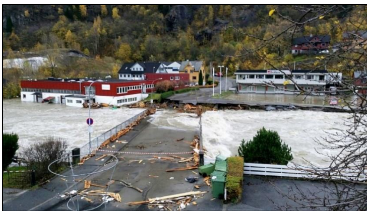
Figur 8: Hjøлло bro under flommen i 2014, markert i Figur 7 som «brokollaps». Broa ble totalskadet i 2014, men ble bygget opp igjen. Under flommen i 2018, sto den derimot i fare for å kollapse nok en gang (Gunnar Moland/NRK, 2014).
