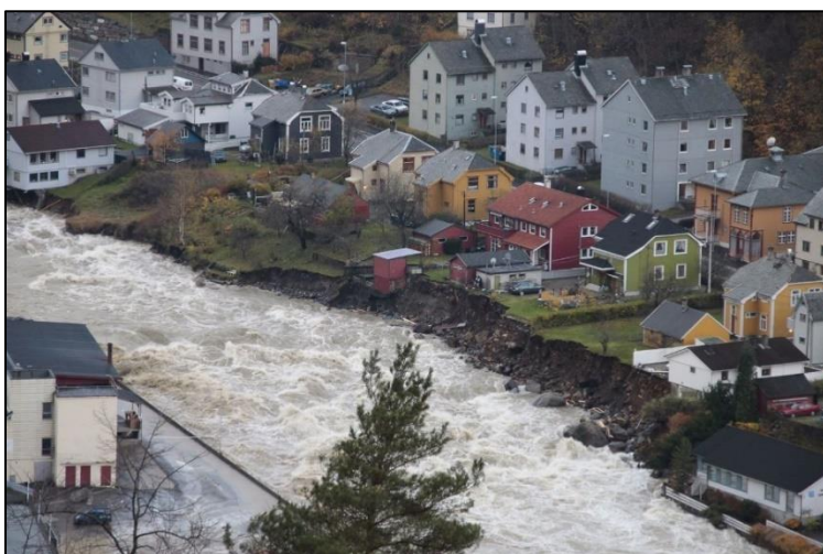
Figur 9: Bildet viser området der de fire bolighusene (Hus 1, 2, 3 og 4 i Figur 7) ble tatt av elva under flommen i 2014. Av bildet framkommer det tydelig hvordan elva eroderte seg nedover i landskapet (Terje Læg Reid/Aftenposten, 2014).
