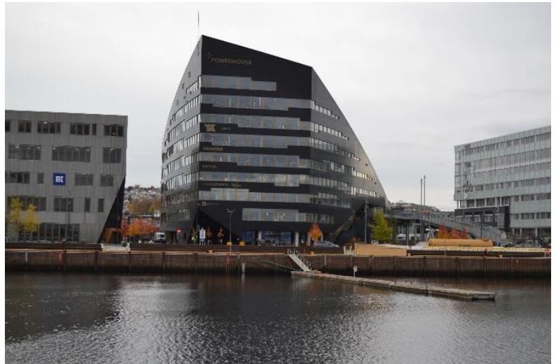
Figur 7: Powerhouse Brattørkaia (Foto: Håkon Hattrem).
