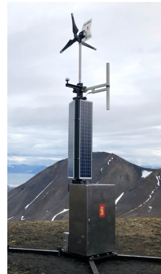
Figur 25: Kystverkets AIS basestasjon på Svalbard (kilde: https://www.tv2.no/a/11651762/ )
