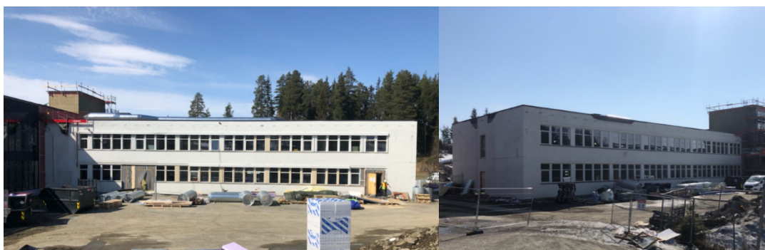
Figur 8 Bildene er tatt av prosjektleder for byggeprosjektet, Berntsen, og viser fasadeløsningen på rehabiliteringsbygget
