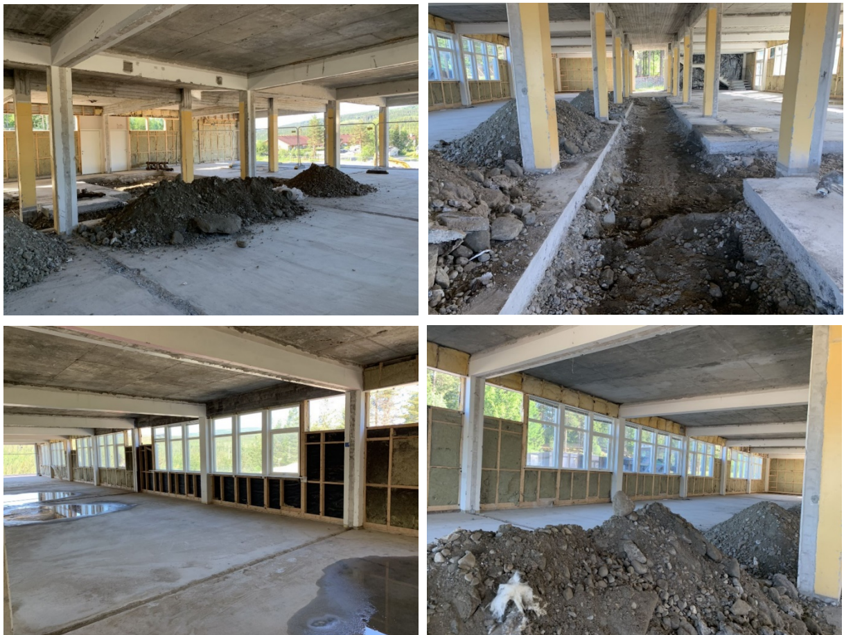
Figur 3 viser betongbygget som det sto da Veidekke startet byggeprosessen. Bildene er tildelt fra ekstern veileder Berntsen.
