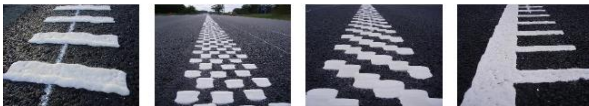
Figur 1. Linjetyper som kan produseres med ekstruderingsško og tilhørende styringsboks, hentet fra Lærebok vegoppmerking Nr. 452.
