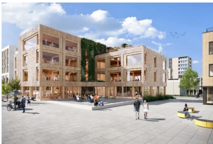
Figur 2.11: Kontorbygget som bygges av AF Eiendom og Höegh Eiendom (Byggeindustrien, 2021).
