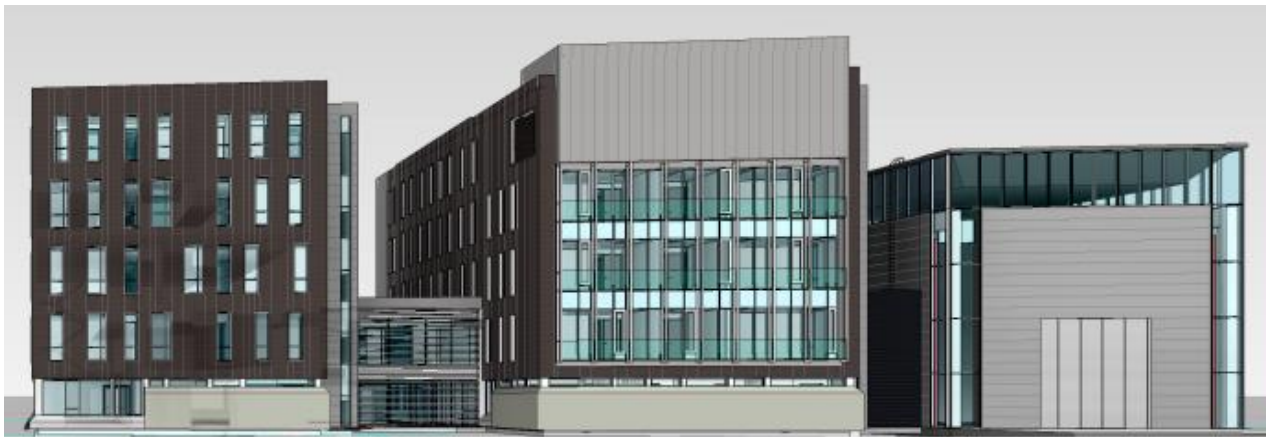
Figur 6 - Fasade; gavelvegg Nord-vest. Arkitektmodell av hele bygningsmassen på tomt OP/K1. EAB Enginerer disponerer bygget i mitten, samt den sammenføyede testhallen. (KONTUR, 2020, 26. Juni)
