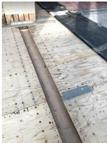
Figur 44 - Kerto – Q-platene festes til hovedbjelkene og gitterbjelkene med skruer – samme prinsipp som TRE8 dekkene i Mjøstårnet i Brumunddalen Foto: lånt av Jan Steinar Egenes/NTNU Gjøvik
