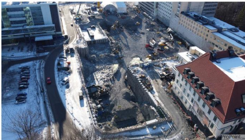
Bildetekst: Dronebilde fra byggeplassen januar 2021
