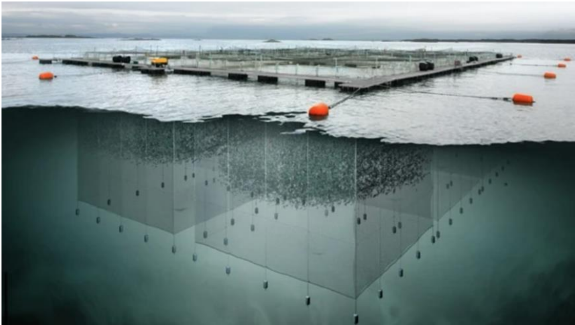
Figur 5: "Et typisk eksempel på et anlegg med stålmerder stabilisert med enkeltlodd." (Aqua Group, 2021)
