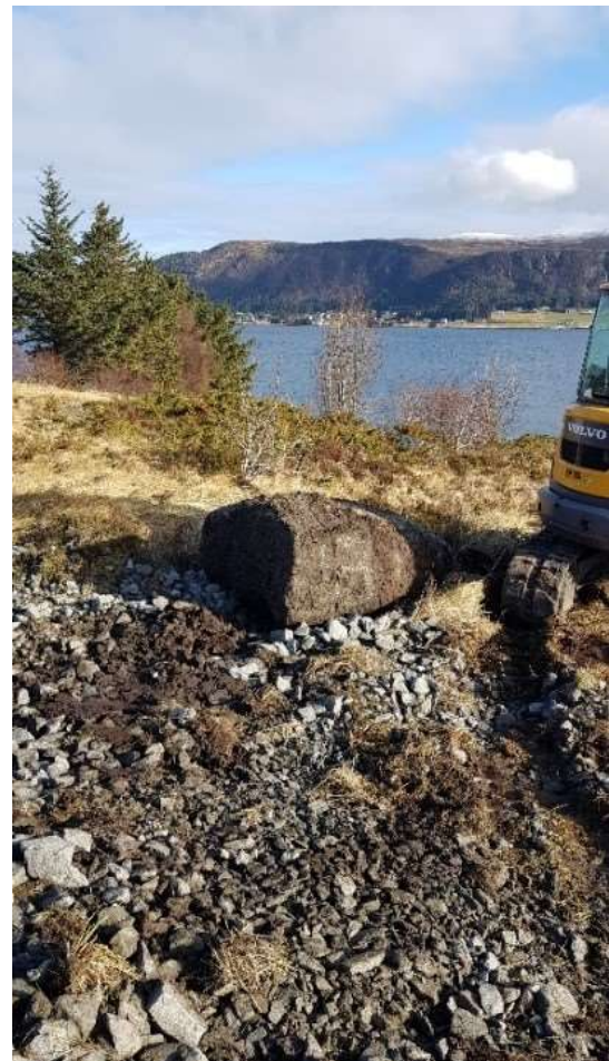
Figur 33: Stor stein som er fjernet fra eksisterende overbygning.
