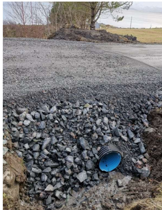
Figur 31: Nyetablert stikkrenne.
