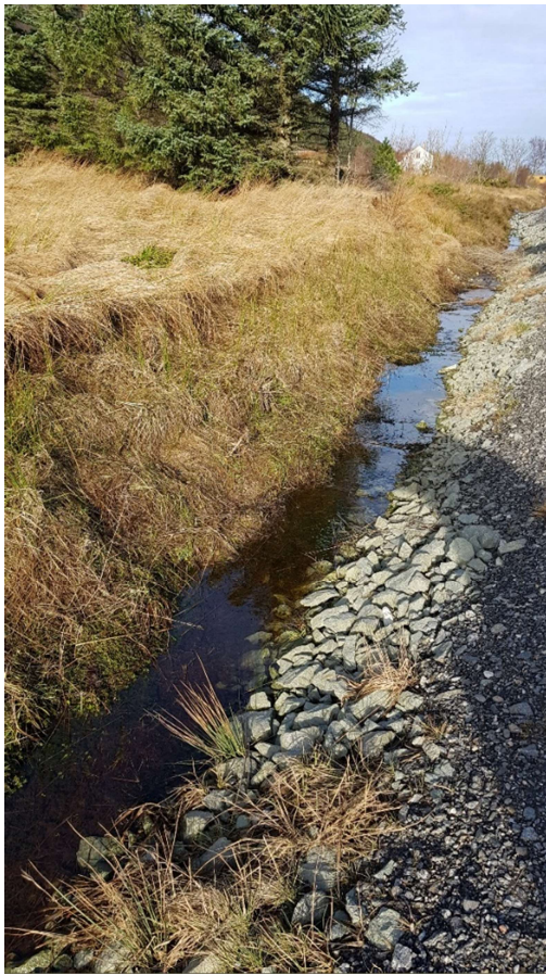
Figur 25: Grøft med vann.
