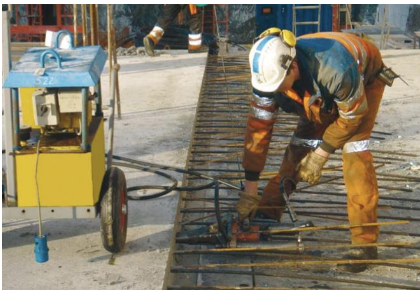
Figur 2.11 Oppspenning av spennkabler (KB Spenneteknikk AS, 2018)
